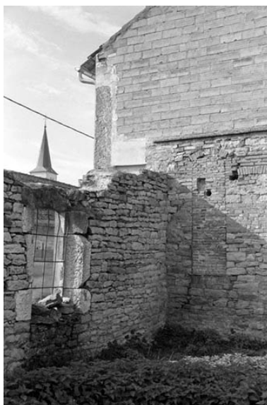
Baie murée, vestige d'un four.
