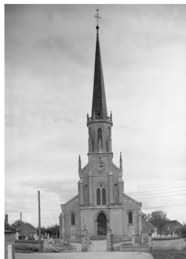
Elévation antérieure Phot. Michel Thierry IVR26_19852101221V
