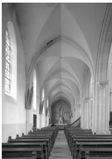
Collatéral gauche, vue prise depuis l'entrée Phot. Michel Thierry IVR26_19852101229V
