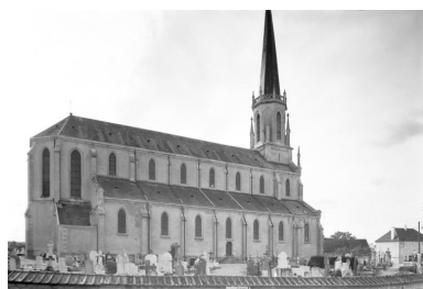
Elévation gauche Phot. Michel Thierry IVR26_19852101223V
