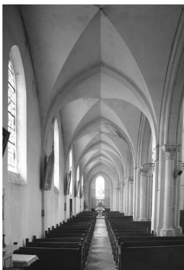
Collatéral droit, vue prise depuis l'entrée Phot. Michel Thierry IVR26_19852101228V
