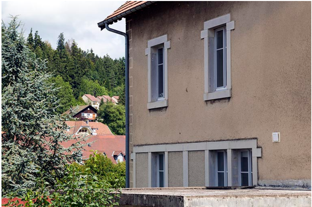
Façade latérale gauche : fenêtres multiples.
