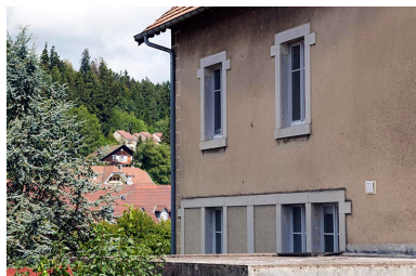
Façade latérale gauche : fenêtres multiples.
