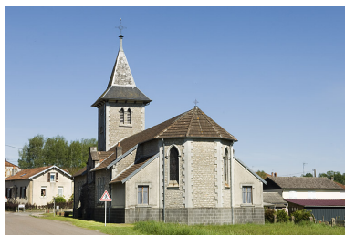
Vue générale du chevet. Phot. Jérôme Mongreville IVR43_20127000176NUC2A
