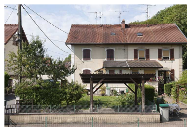
Face est d'une habitation à 4 logements. Phot. Jérôme Mongreville IVR43_20112502015NUC4A
