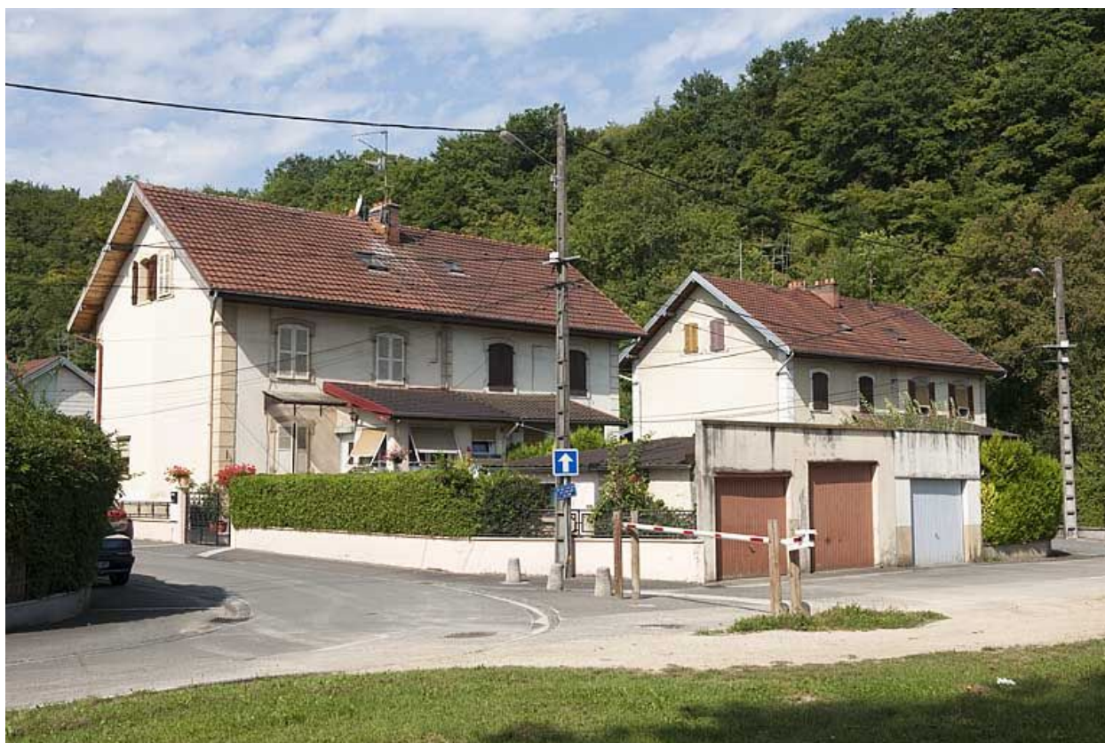
Habitations à 4 logements vues de trois quarts.
