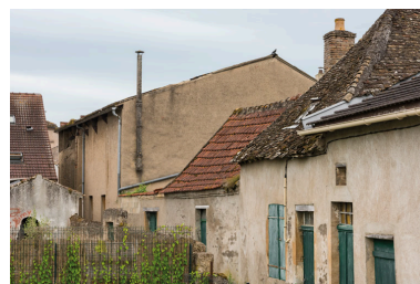
Façade postérieure, de trois quarts gauche. Phot. Pierre-Marie Barbe-Richaud IVR26_20257100362NUC4A
