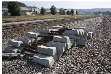
Vue d'ensemble de traverses Stradal, en gare de Champagnole. Phot. Yves Sancey IVR43_20083900890NUC2A
