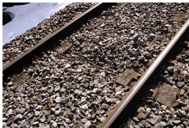
Vue plongeante sur une traverse Sateba, à proximité du pont sur la R.D. 18 (PK 045.208), commune de Morbier. Phot. Yves Sancey IVR43_20053900360ZA
