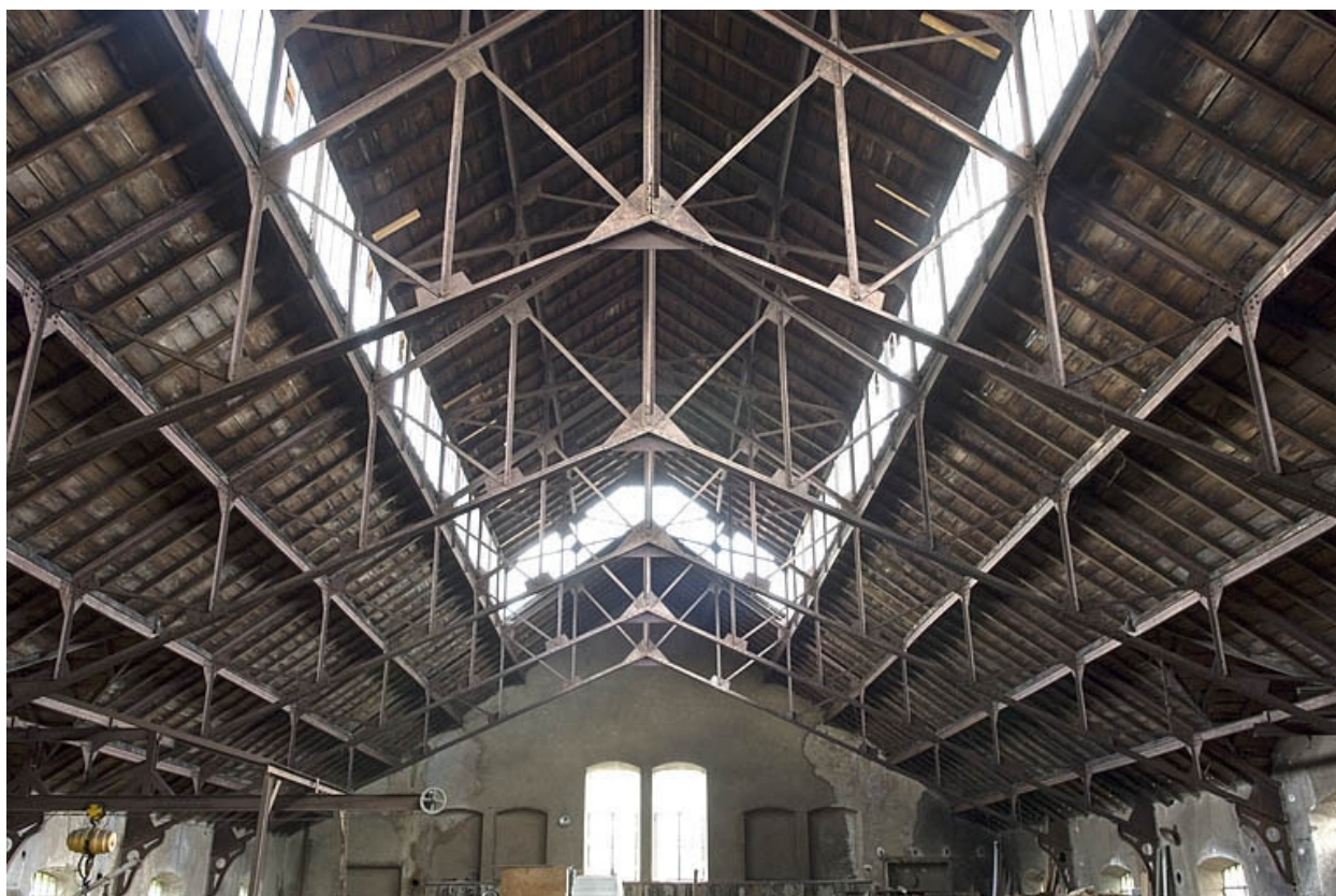
Vue de la charpente métallique.
