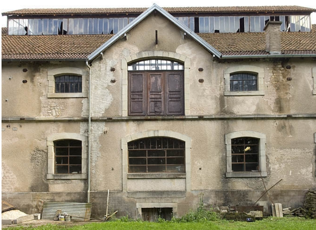
Travée centrale de la façade postérieure.
