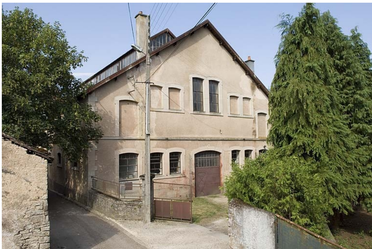
Vue sur le pignon oriental.
