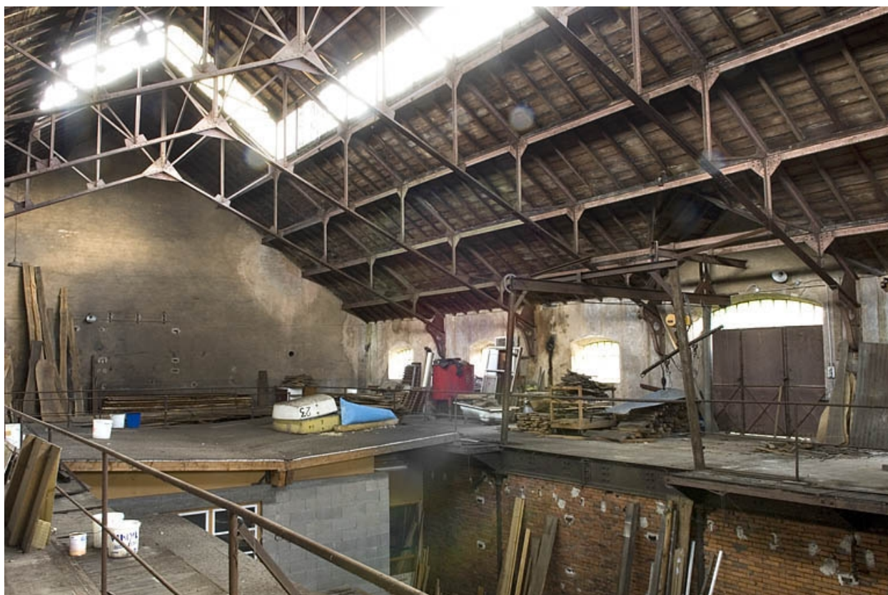
Partie ouest du comble.
