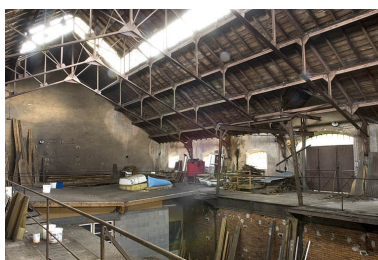
Partie ouest du comble. Phot. Jérôme Mongreville IVR43_20067000652NUCA
