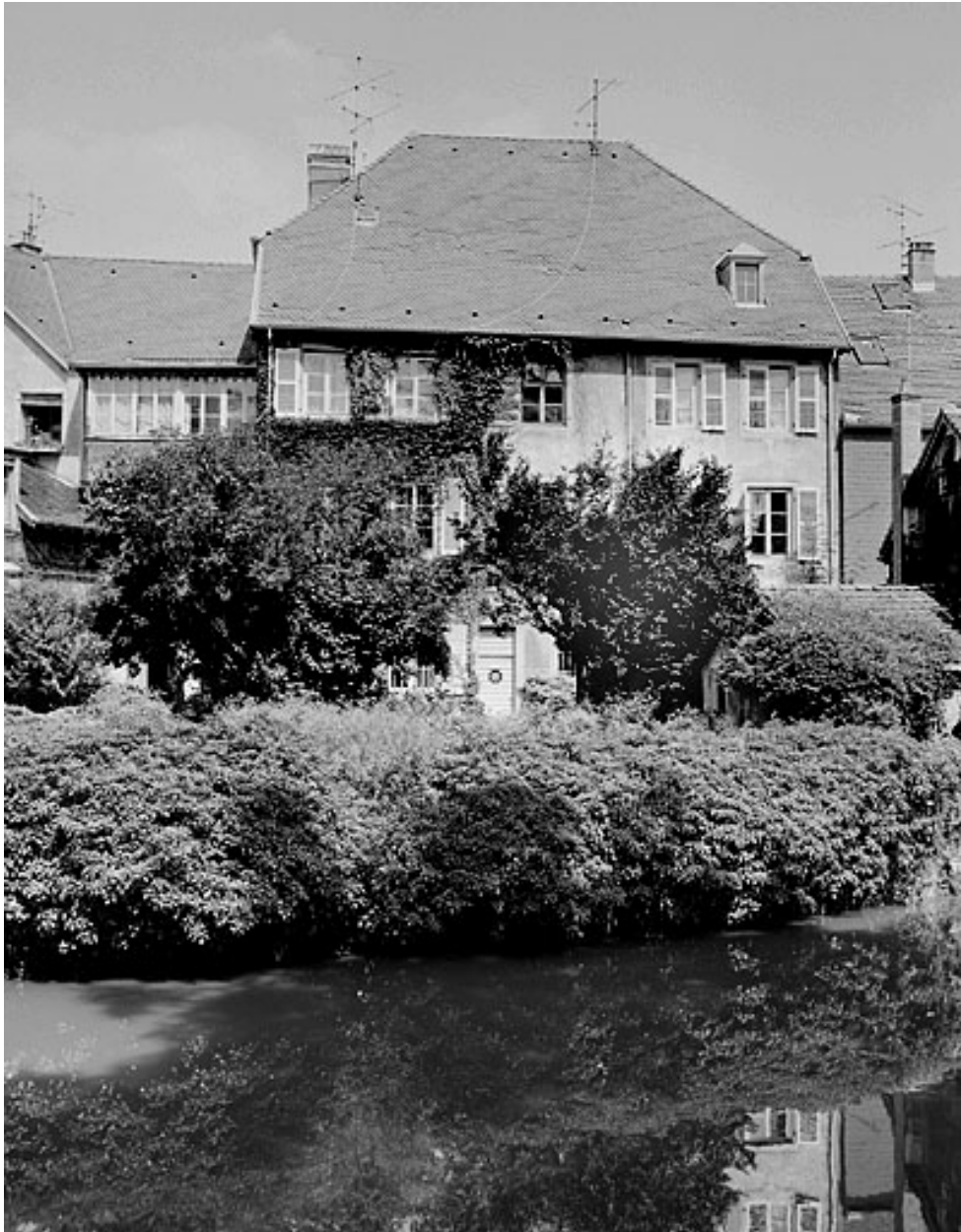
Façade sur jardin du corps de bâtiment principal.
