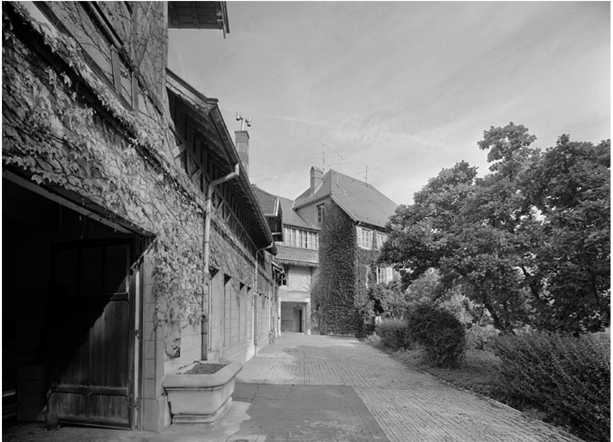
Cour des écuries et des remises.
