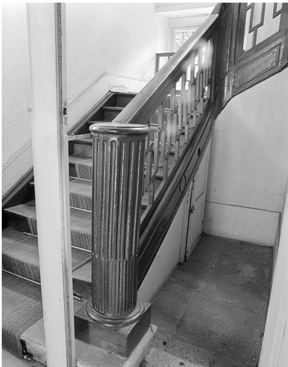
Départ de l'escalier du corps de bâtiment principal.
