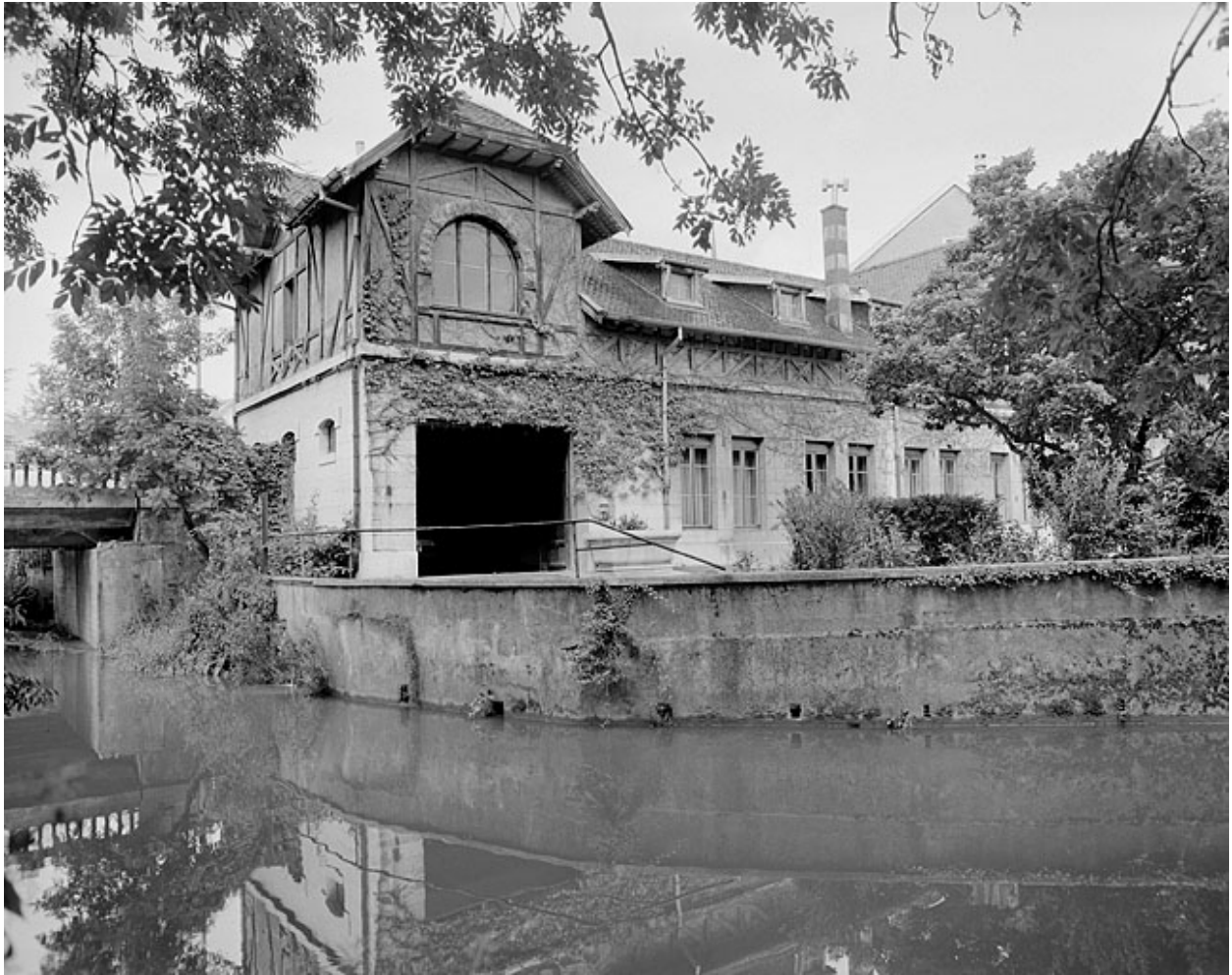
Partie méridionale des écuries et des remises.
