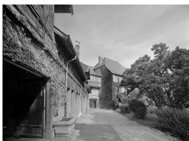
Cour des écuries et des remises. Phot. Jérôme Mongreville IVR43_19872501204V
