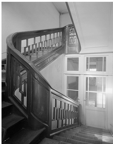
Première volée d'escalier du corps de bâtiment principal. Phot. Jérôme Mongreville IVR43_19872501205V
