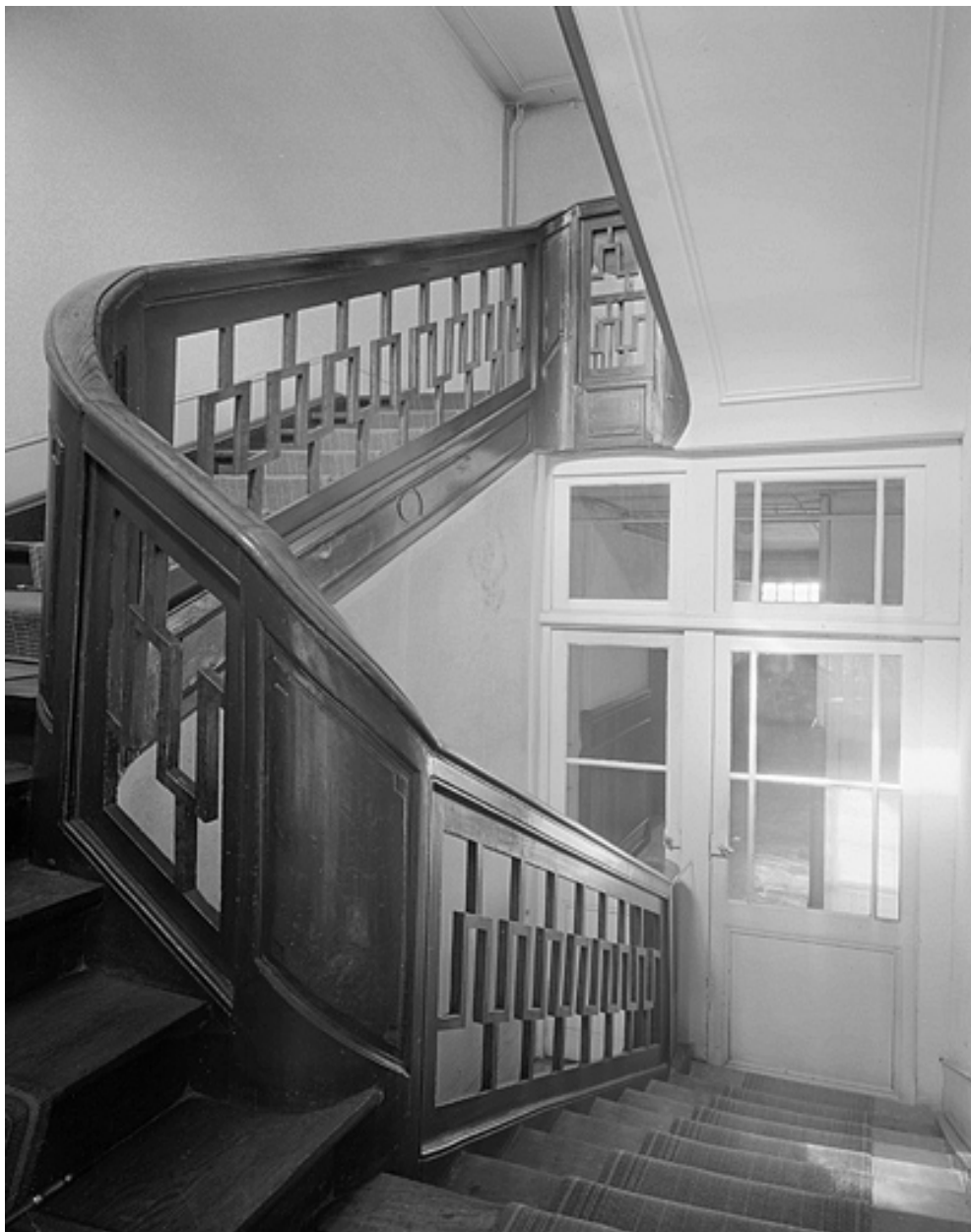
Première volée d'escalier du corps de bâtiment principal.
