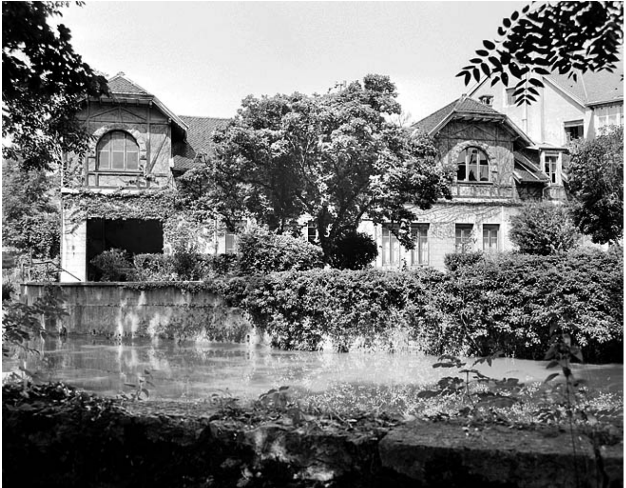
Façade sur cour des écuries et des remises.
