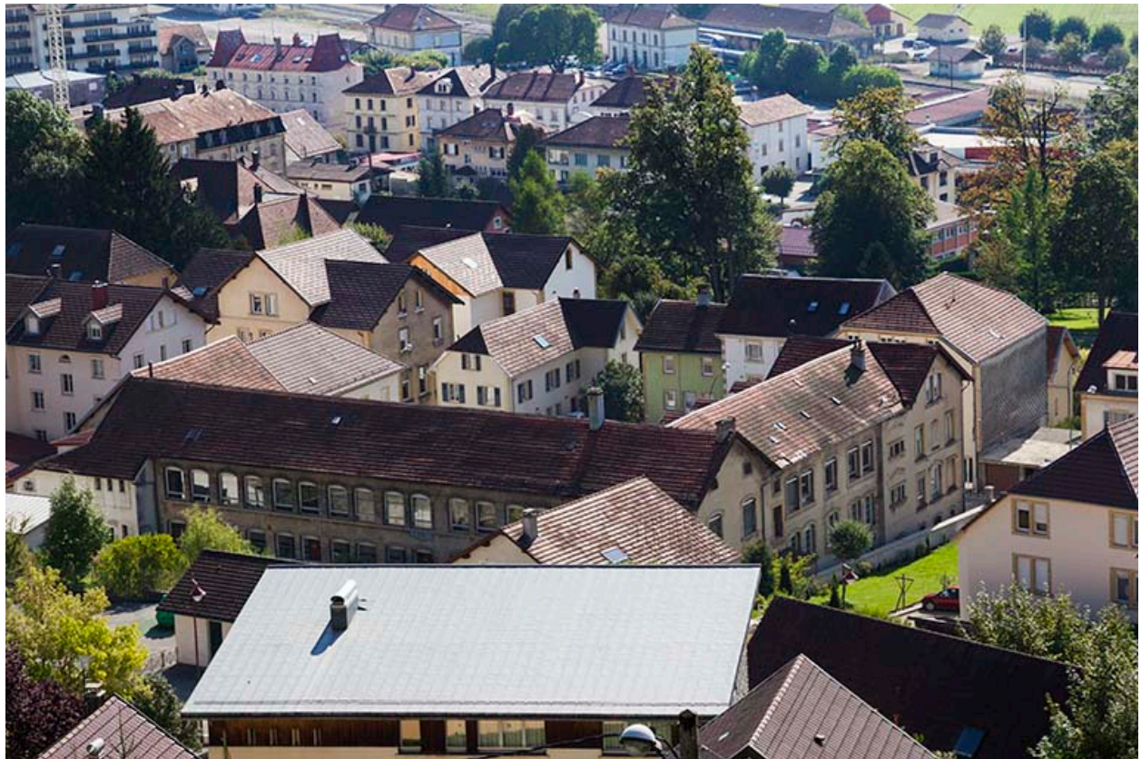
Vue d'ensemble plongeante, depuis le nord-ouest.
