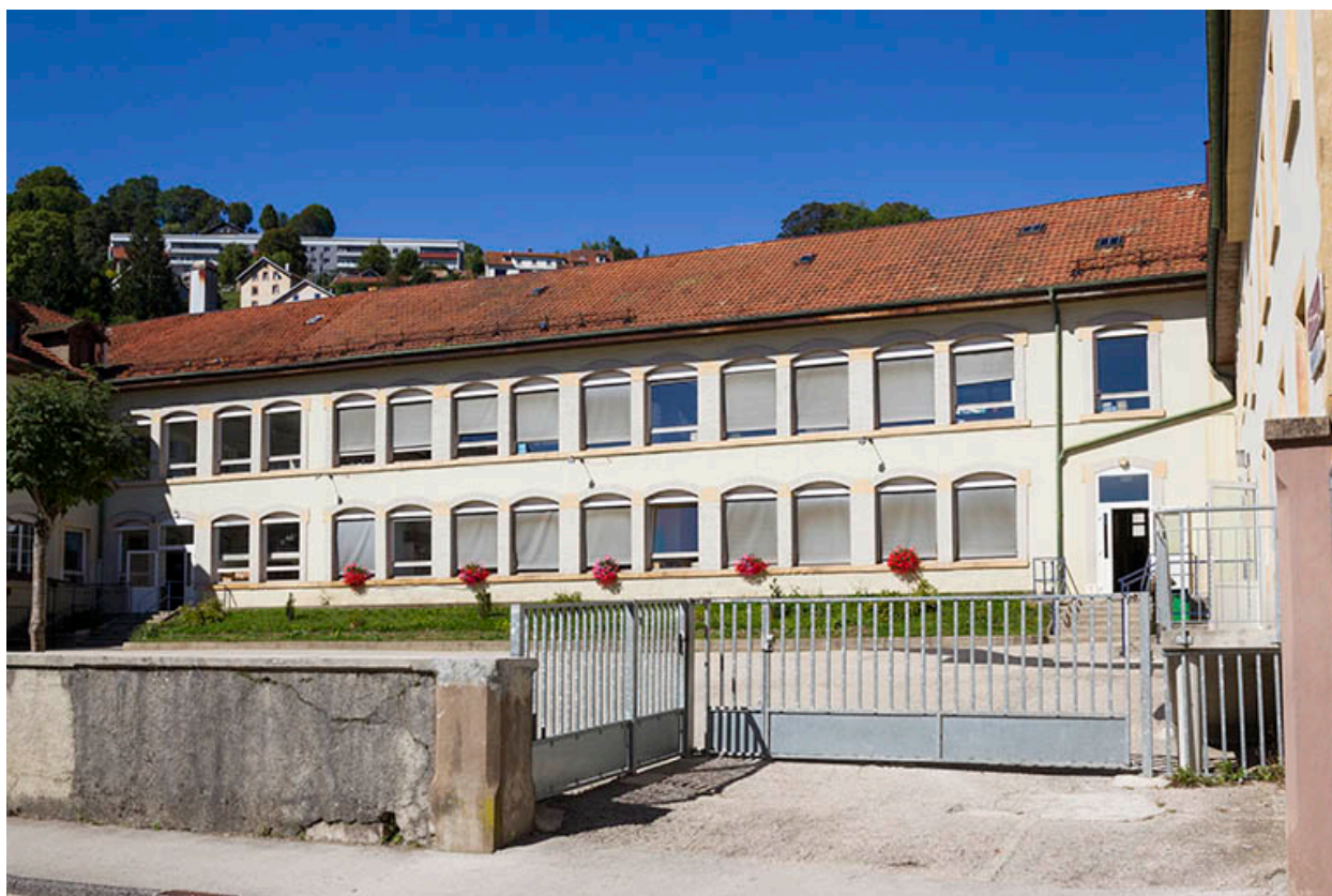
Aile nord : façade antérieure.
