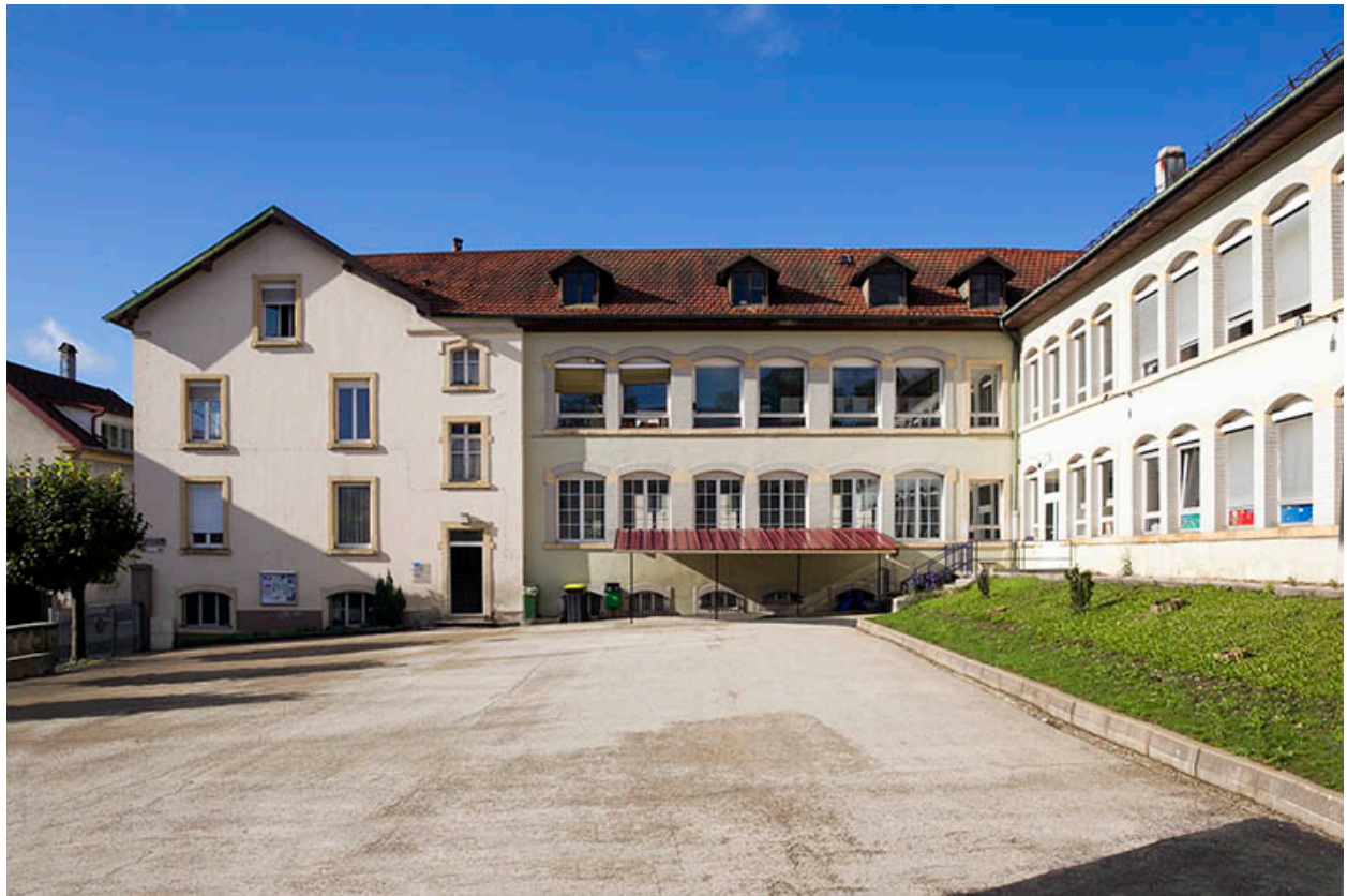
Aile ouest : façade orientale (sur cour).
