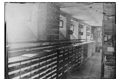
[Intérieur d'un magasin], [1902]. Phot. Sonia Dourlot IVR43_20182501620NUC4A
