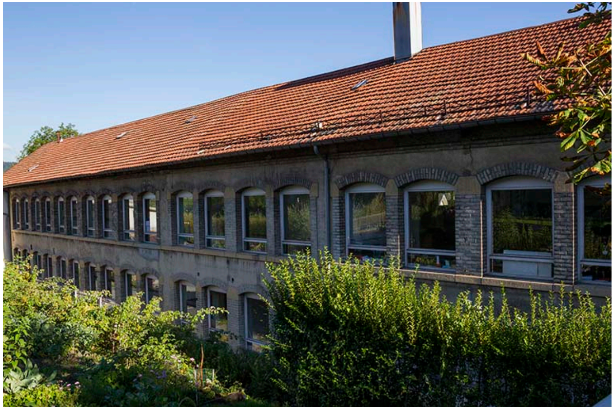
Aile nord : façade postérieure.
