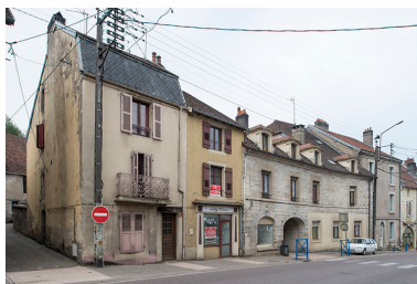
Vue générale. Phot. Jérôme Mongreville IVR43_20177000459NUC4A
