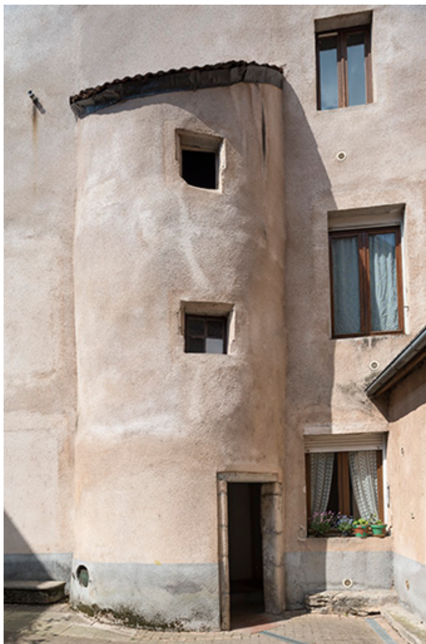
Tour comprenant un escalier, cour intérieure.
