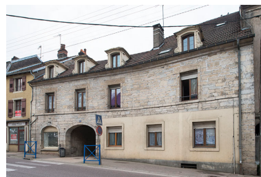
La façade principale depuis la rue. Phot. Jérôme Mongreville IVR43_20177000457NUC4A
