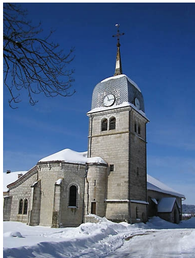
Vue générale de l'abside et du clocher.
