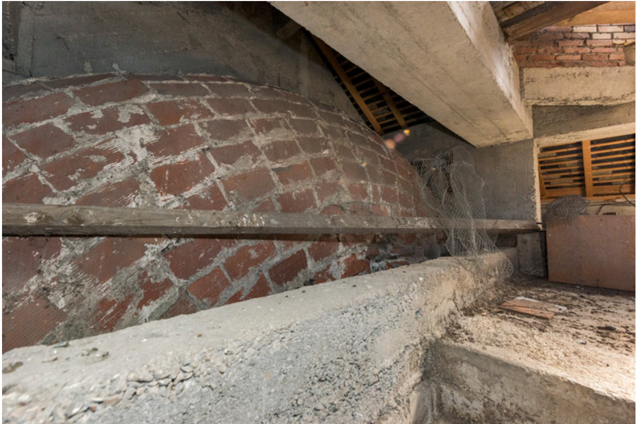
Voûte et charpente.
