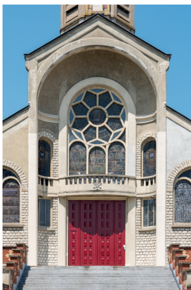
Détail de la partie centrale de la façade antérieure. Phot. Pierre-Marie Barbe-Richaud IVR26_20238901142NUC4A
