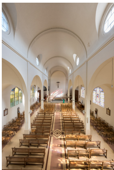
Nef. Vue en direction du chœur depuis la tribune. Phot. Pierre-Marie Barbe-Richaud IVR26_20238901165NUC4A
