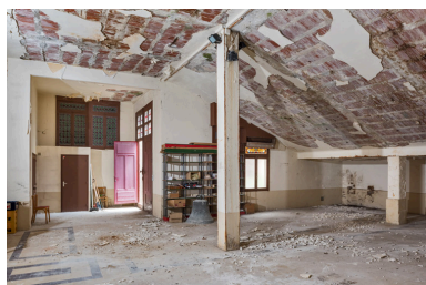
Crypte. Vue en direction de l'entrée est. Phot. Pierre-Marie Barbe-Richaud IVR26_20238901236NUC4A
