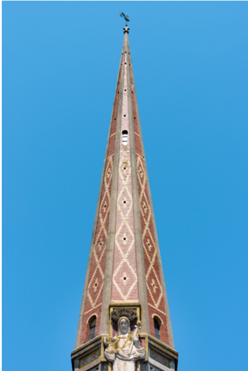
Toiture du clocher. Vue d'ensemble.
