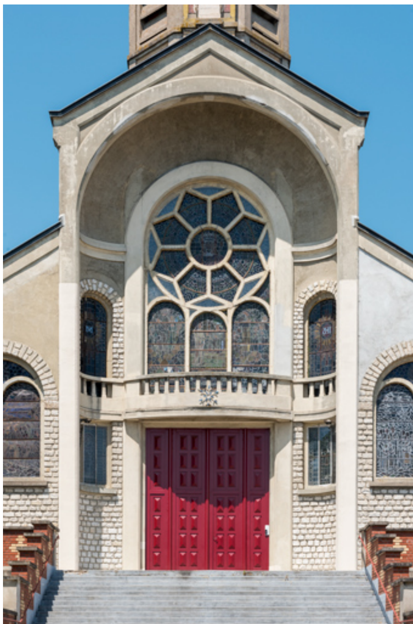
Détail de la partie centrale de la façade antérieure.
