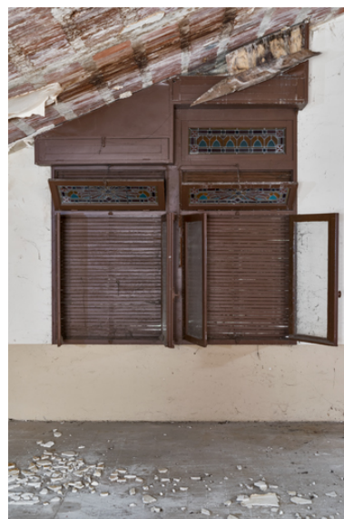
Fenêtre de la crypte. Phot. Pierre-Marie Barbe-Richaud IVR26_20238901244NUC4A
