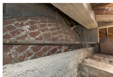
Voûte et charpente. Phot. Pierre-Marie Barbe-Richaud IVR26_20238901170NUC4A
