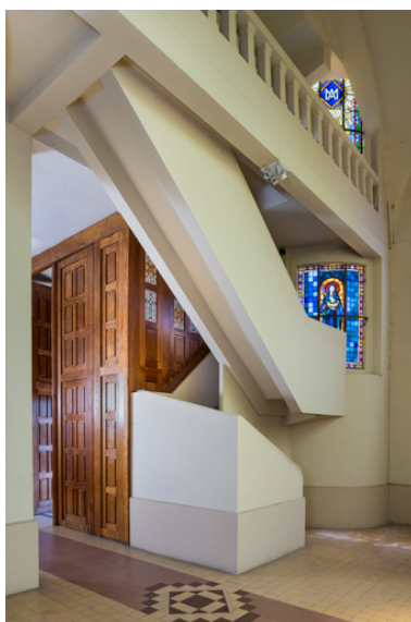
Escalier menant à la tribune sud. Phot. Pierre-Marie Barbe-Richaud IVR26_20238901144NUC4A
