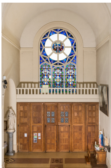
Bras gauche du transept. Vue d'ensemble. Phot. Pierre-Marie Barbe-Richaud IVR26_20238901176NUC4A
