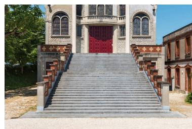
Escalier principal menant au parvis. Phot. Pierre-Marie Barbe-Richaud IVR26_20238901143NUC4A
