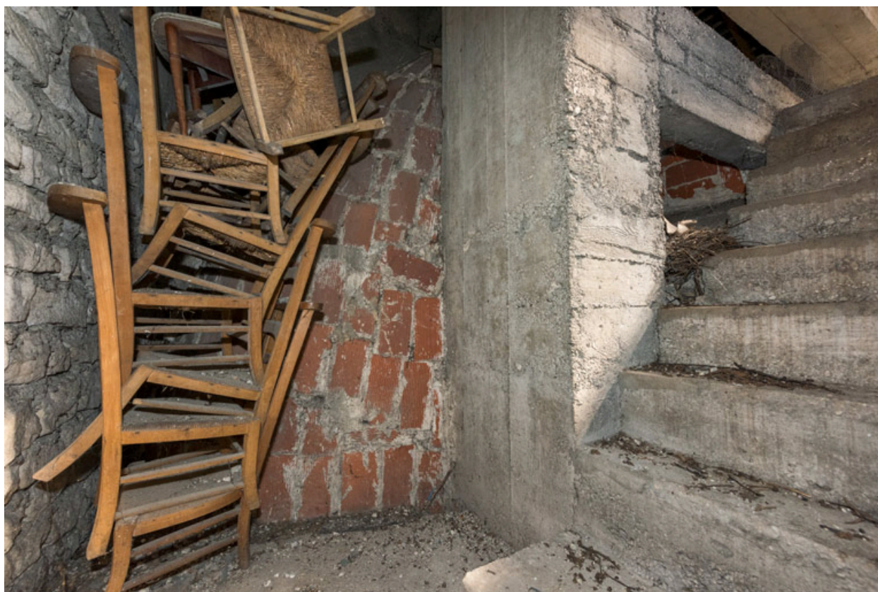
Voûte et escalier du clocher.
