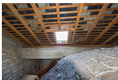
Voûte de la chapelle des fonts et charpente. Phot. Pierre-Marie Barbe-Richaud IVR26_20238901168NUC4A
