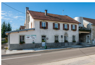
Façade antérieure. Phot. Jérôme Mongreville IVR43_20142501191NUC4A
