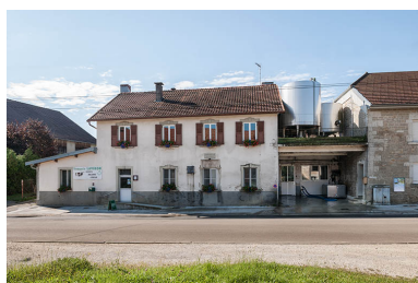
Vue de face. Phot. Jérôme Mongreville IVR43_20142501192NUC4A
