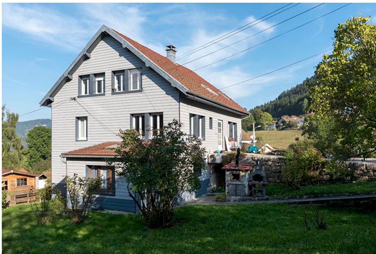
Façades antérieure et latérale gauche.
