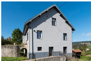
Façade latérale droite. Phot. Sonia Dourlot IVR43_20162501395NUC4A
