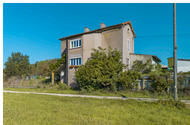
Façade arrière avec l'ajout d'un avant-corps central. Phot. Thierry Kuntz IVR26_20197100504NUC4A
