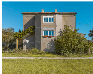
Façade arrière avec l'ajout d'un avant-corps central. Phot. Thierry Kuntz IVR26_20197100506NUC4A
