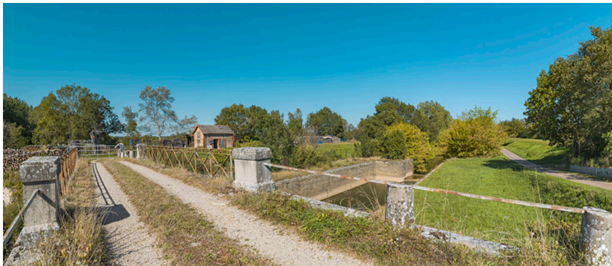
Le site d'écluse vu depuis le pont sur écluse.
