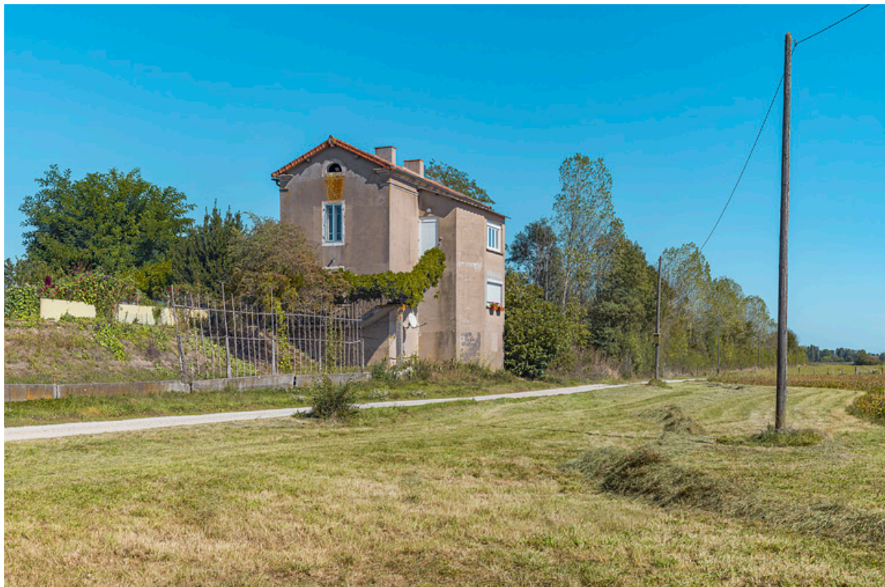
La maison éclusière, vue d'aval, dans son environnement paysager.
