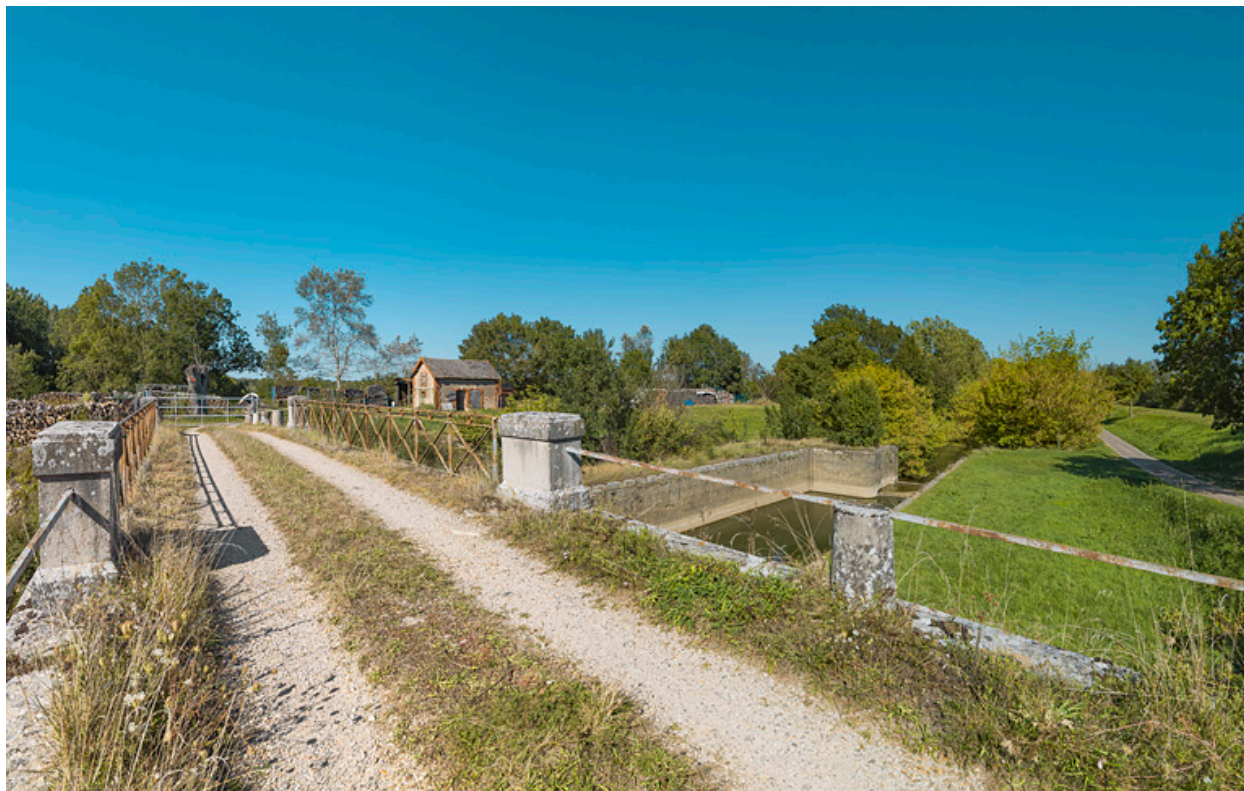
Le site d'écluse vu depuis le pont sur écluse.
