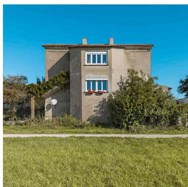
Façade arrière avec l'ajout d'un avant-corps central. Phot. Thierry Kuntz IVR26_20197100507NUC4A
