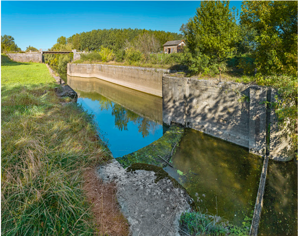
Le sas et l'emplacement des portes.
