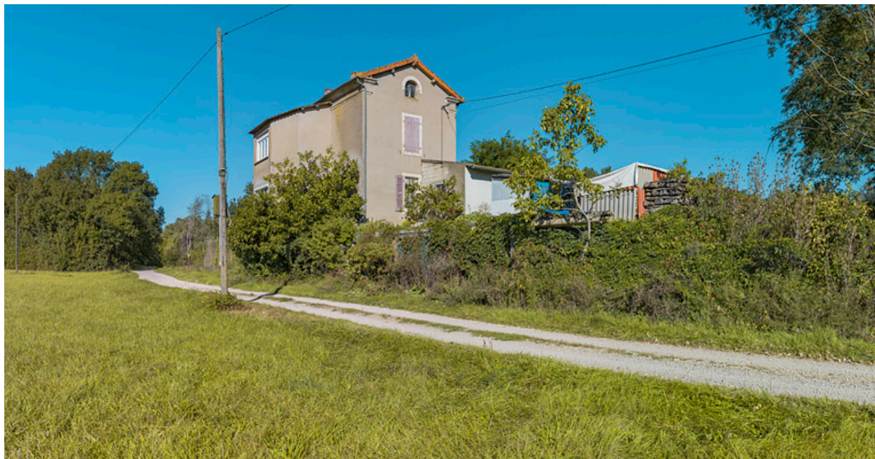
Mur pignon et arrière de la maison éclusière.
