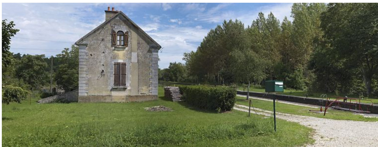
Maison éclusière : pignon regardant vers l'aval.
