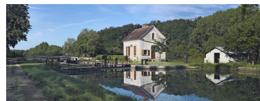
Vue d'ensemble du site pris d'amont. Phot. Thierry Kuntz IVR26_20118900045NUC4A
