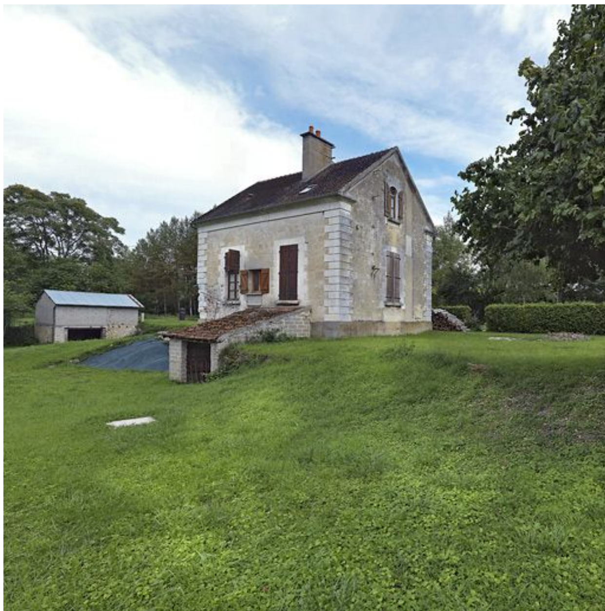
Maison éclusière : vue de 3/4 arrière.
