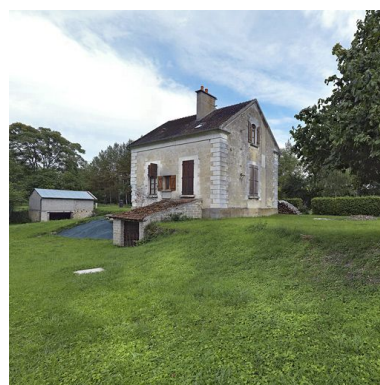
Maison éclusière : vue de 3/4 arrière. Phot. Thierry Kuntz IVR26_20118900056NUC4A
