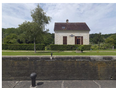
Maison éclusière : mur gouttereau sur canal. Phot. Thierry Kuntz IVR26_20118900054NUC4A
