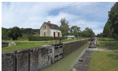
Site vu d'aval. Phot. Thierry Kuntz IVR26_20118900048NUC4A
