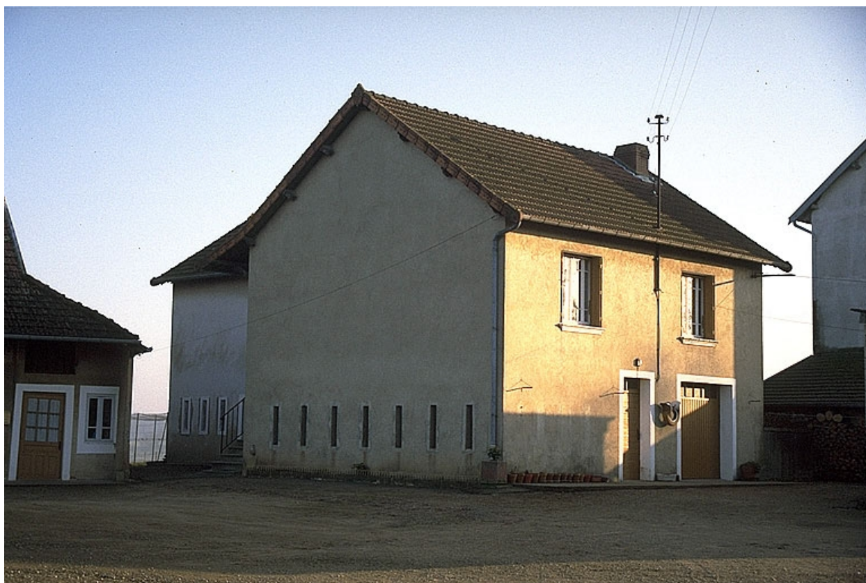
Fromagerie vue du nord.
