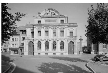
Banque. Façade principale. Phot. Jérôme Mongreville IVR43_19872501073V
