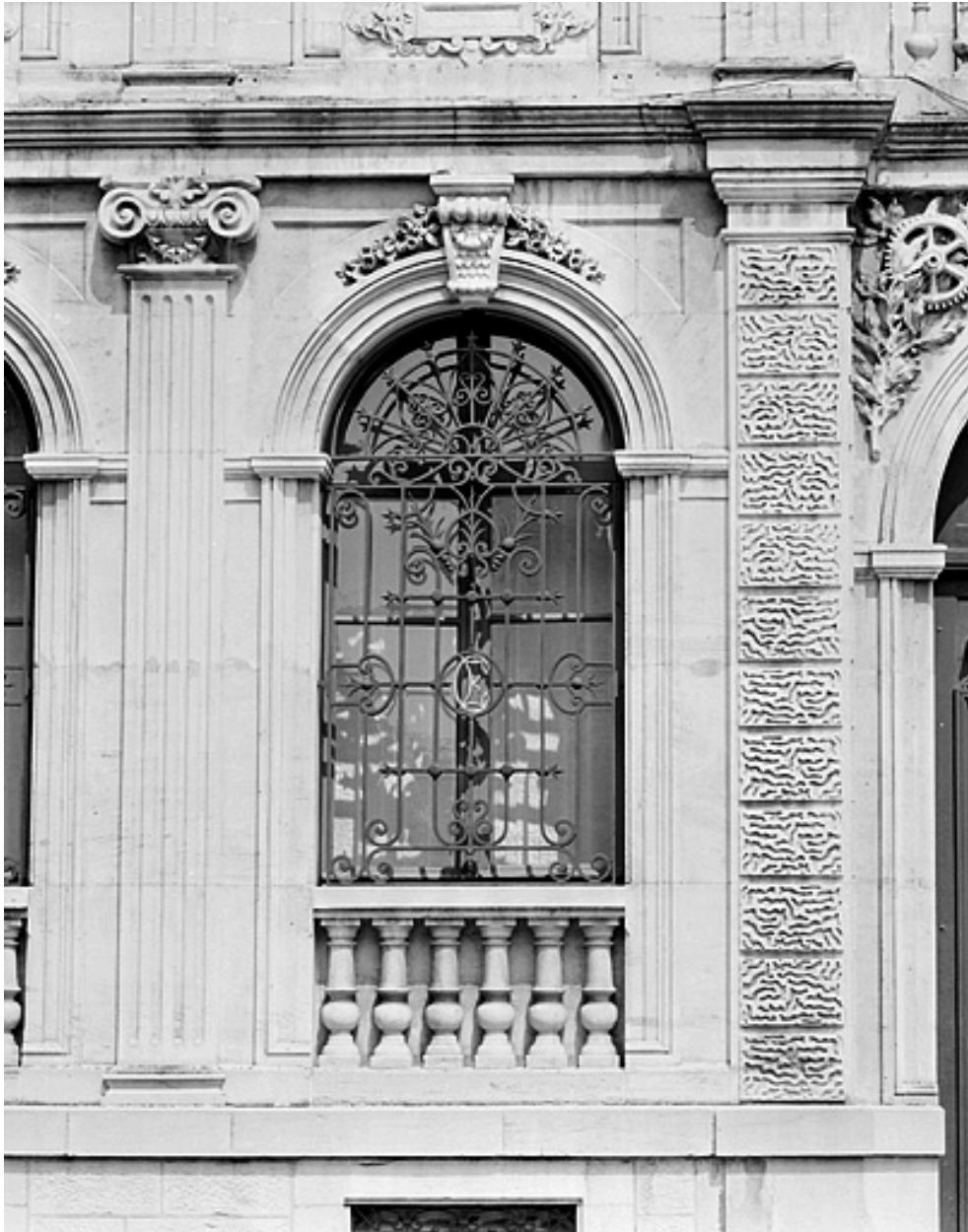
Banque. Façade principale, fenêtre du rez-de-chaussée.
