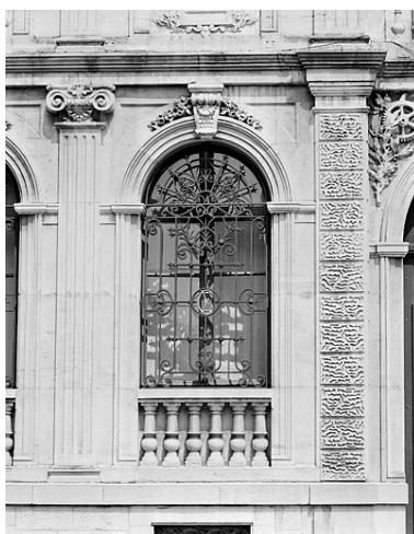
Banque. Façade principale, fenêtre du rez-de-chaussée.
