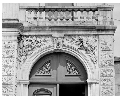
Banque. Façade principale, détail de la porte bâtarde. Phot. Jérôme Mongreville IVR43_19872500925X
