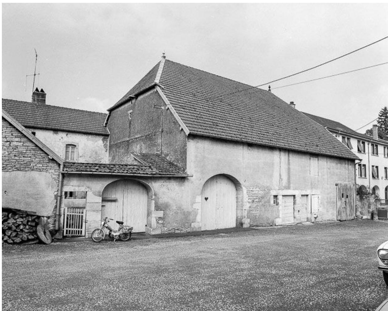
Ferme située rue du Château.
