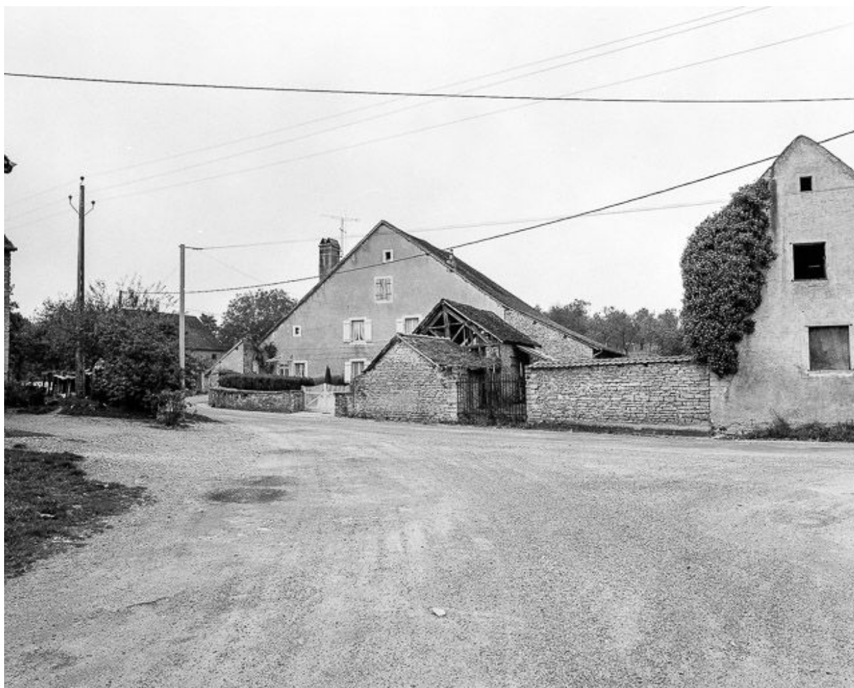
Ferme située rue du Grillot.
