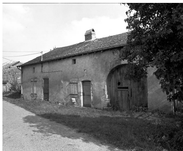
Ferme située rue 10 rue Marquichet. Phot. Dominique Dominguez IVR43_19807000248X
