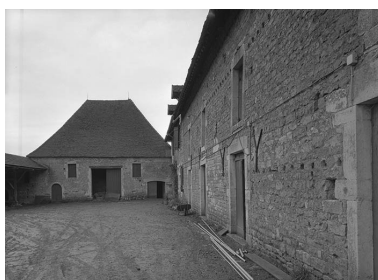
Vue d'ensemble depuis le portail. Phot. Michel Rosso IVR26_19792101961V
