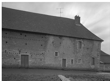
Façade postérieure du logis. Phot. Michel Rosso IVR26_19792101965V
