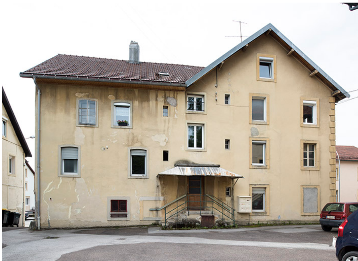
Bâtiment sur rue : façade postérieure.
