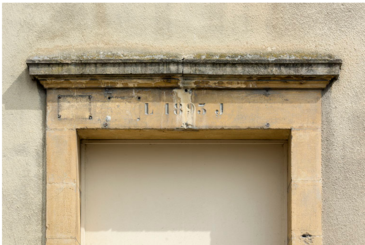
Bâtiment sur rue : linteau daté 1893.
