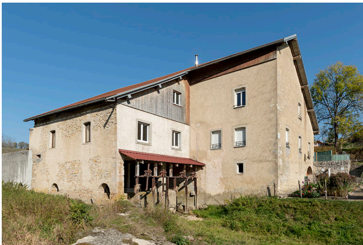
Moulin : façades postérieure et latérale gauche.
