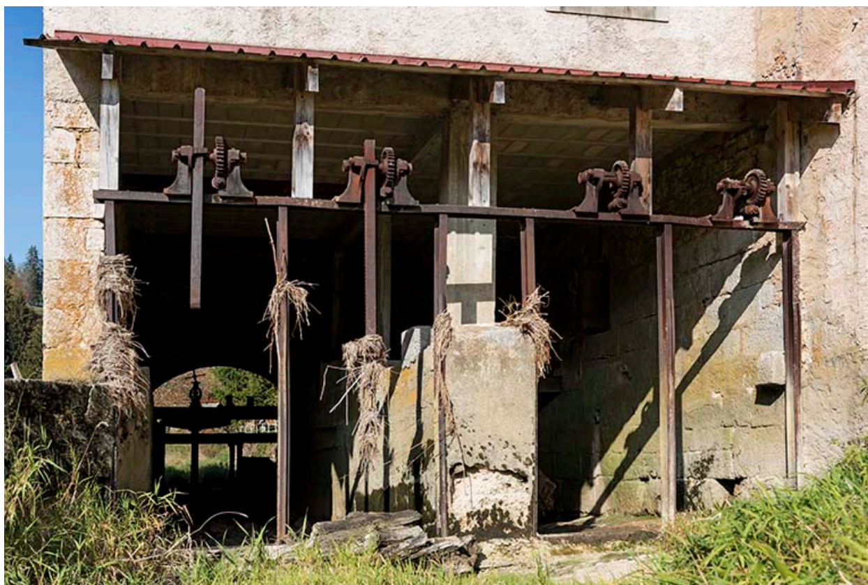
Moulin : vestiges des vannes de prise d'eau.
