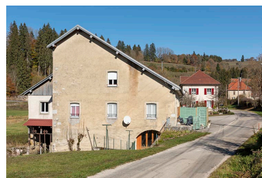
Moulin : façade latérale gauche (sud). Phot. Sonia Dourlot IVR43_20182501759NUC4A
