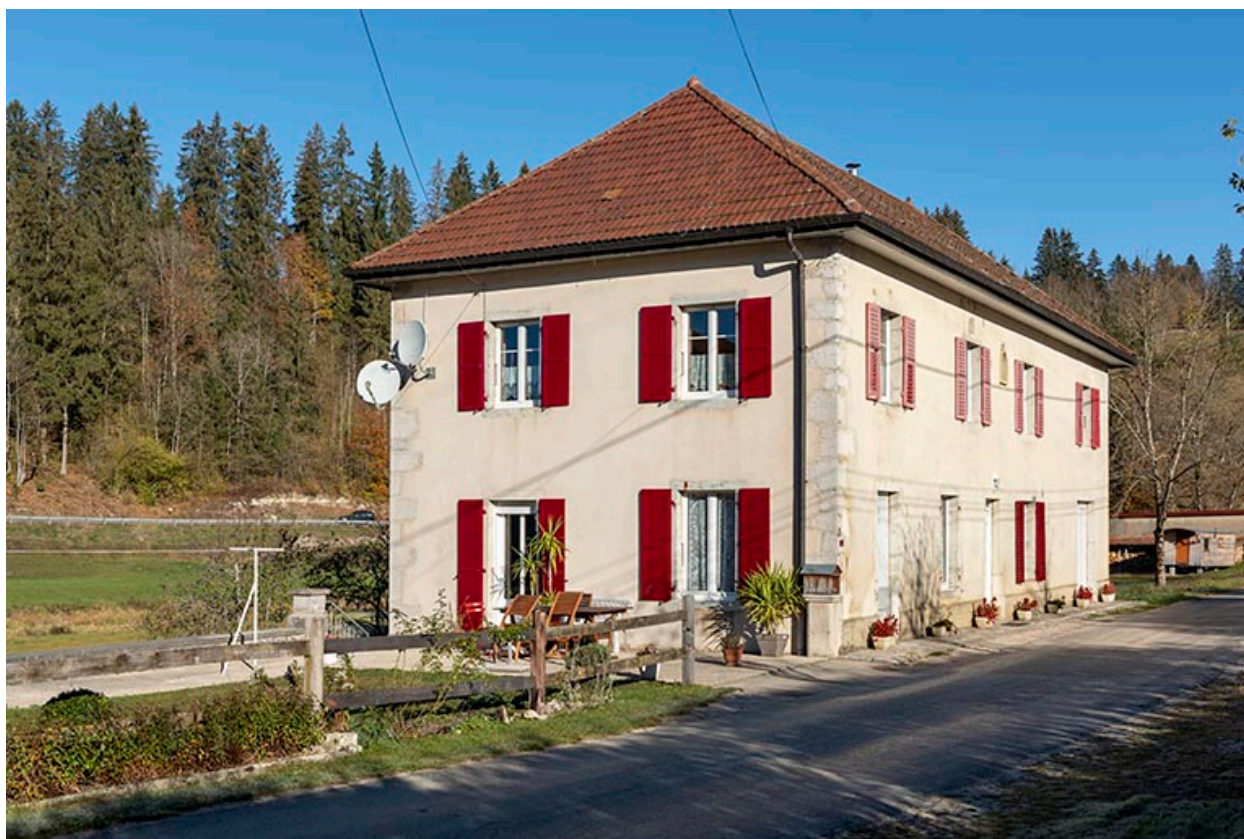
Maison : façades antérieure et latérale gauche.
