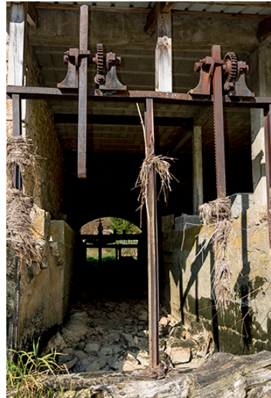
Moulin : vestiges des vannes de prise d'eau gauche. Phot. Sonia Dourlot IVR43_20182501764NUC4A
