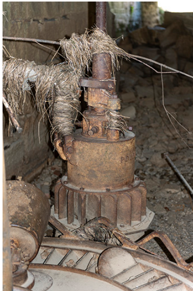
Moulin : transmission de la commande d'admission d'eau. Phot. Sonia Dourlot IVR43_20182501766NUC4A
