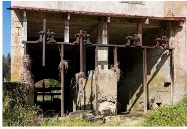
Moulin : vestiges des vannes de prise d'eau. Phot. Sonia Dourlot IVR43_20182501763NUC4A
