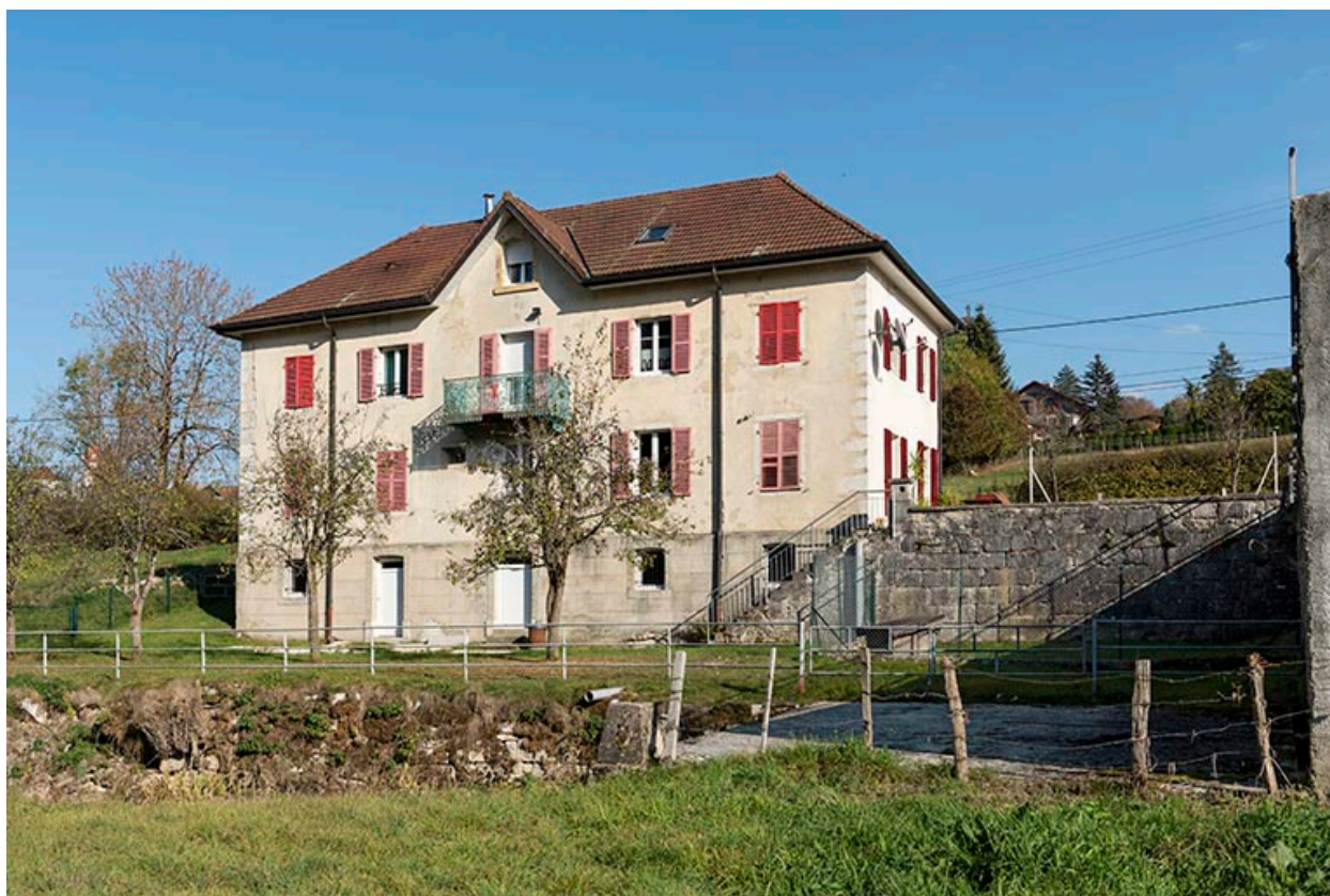
Maison : façade postérieure.
