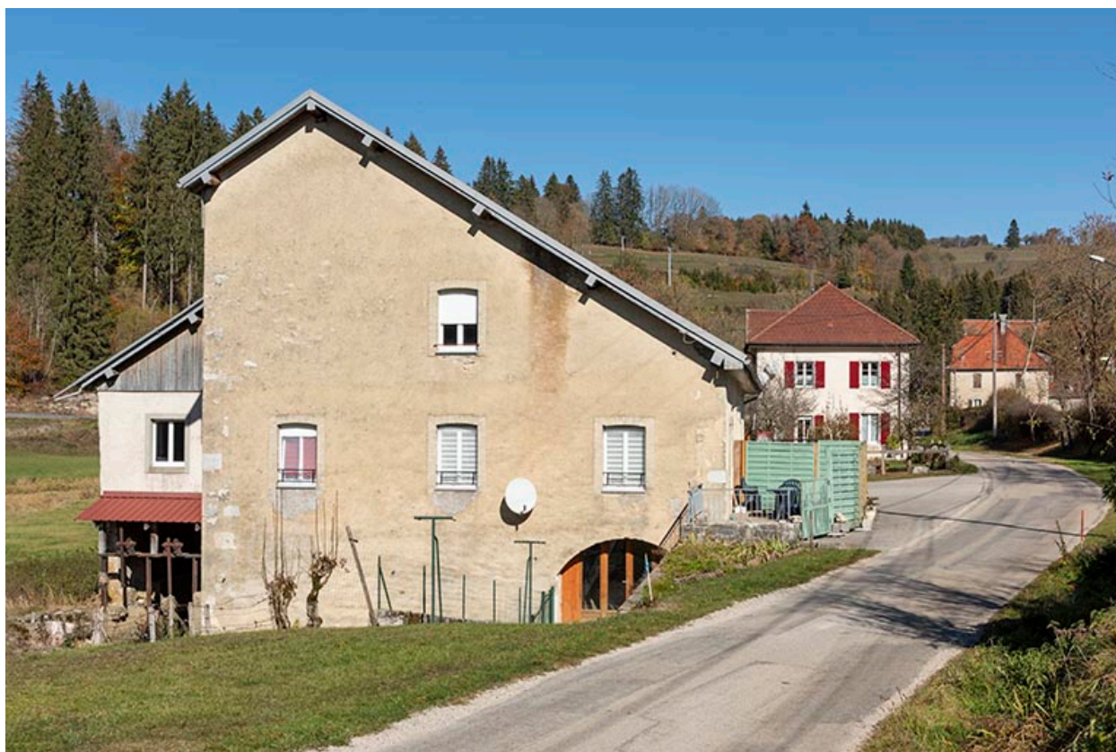
Moulin : façade latérale gauche (sud).
