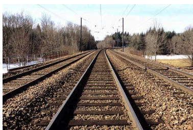
Face supérieure du tablier. La voie de gauche est à destination de La Cluse. Phot. Yves Sancey IVR43_20053900026ZA
