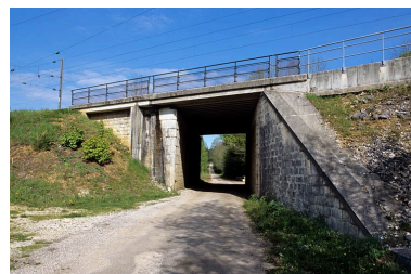
Vue d'ensemble. Phot. Yves Sancey IVR43_20053900022ZA
