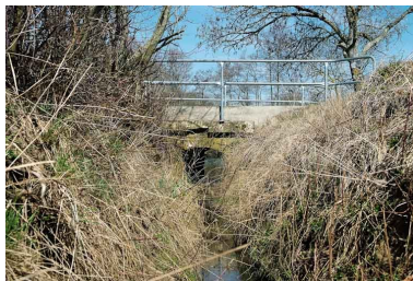
Ponceau, vue rapprochée. Phot. Jean-Luc Duthu IVR26_20107100462NUC2A
