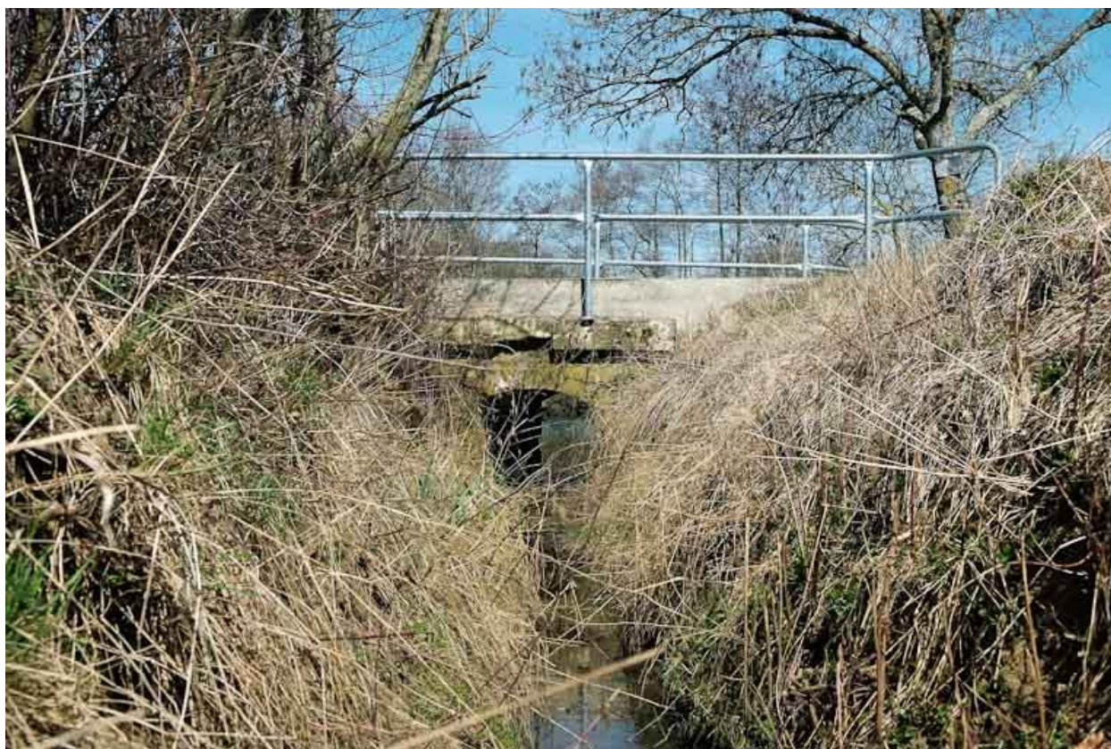
Ponceau, vue rapprochée.
