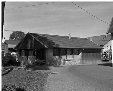
Bureau et magasin industriel. Phot. Yves Sancey IVR43_19973901142X
