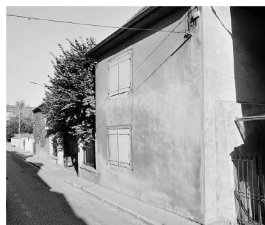
Vue d'ensemble prise de la rue de Belfort. Phot. Jérôme Mongreville IVR43_19872500955X
