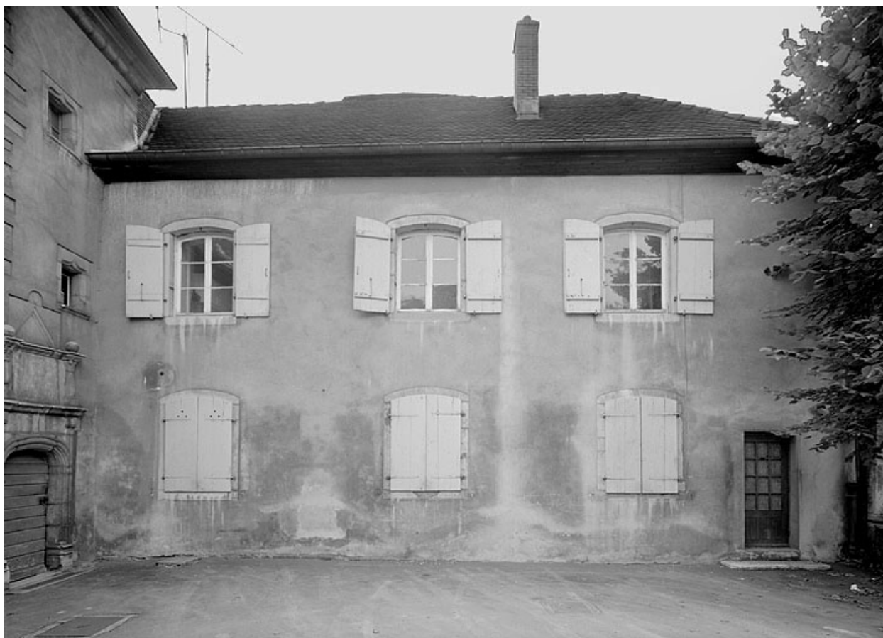
Aile droite. Façade sur la cour.
