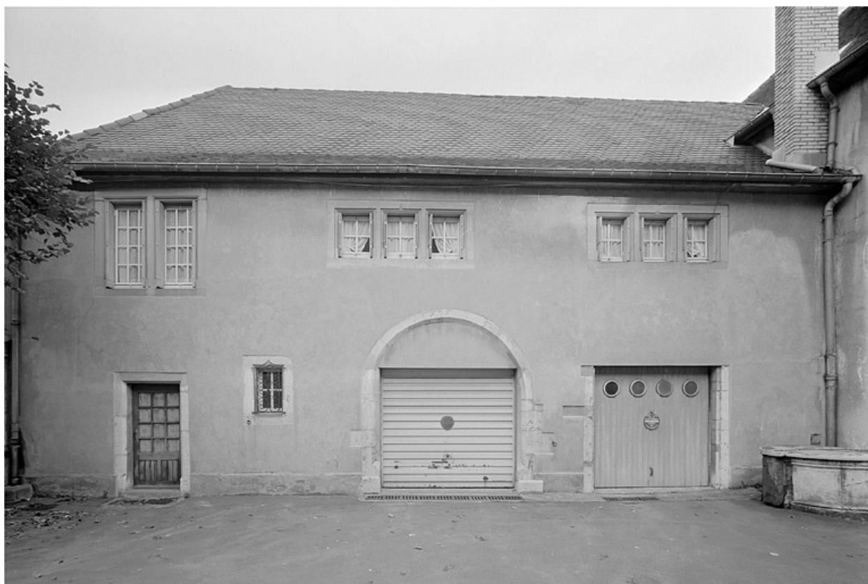
Aile gauche. Façade sur la cour.
