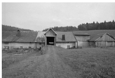
Façade postérieure avec pont de grange. Phot. Yves Sancey IVR43_19752500937Z
