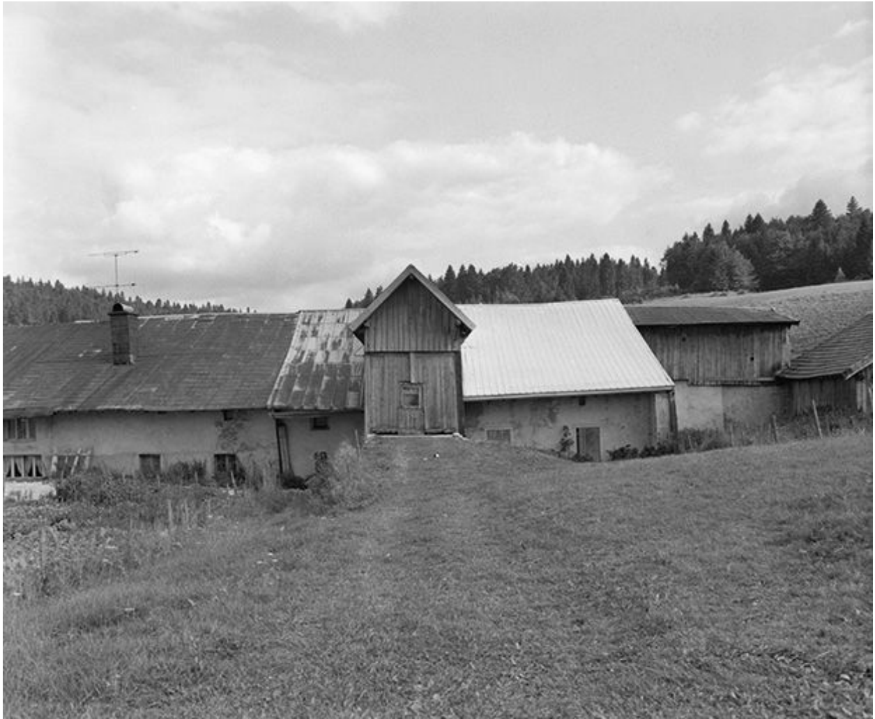
Façade postérieure avec pont de grange.
