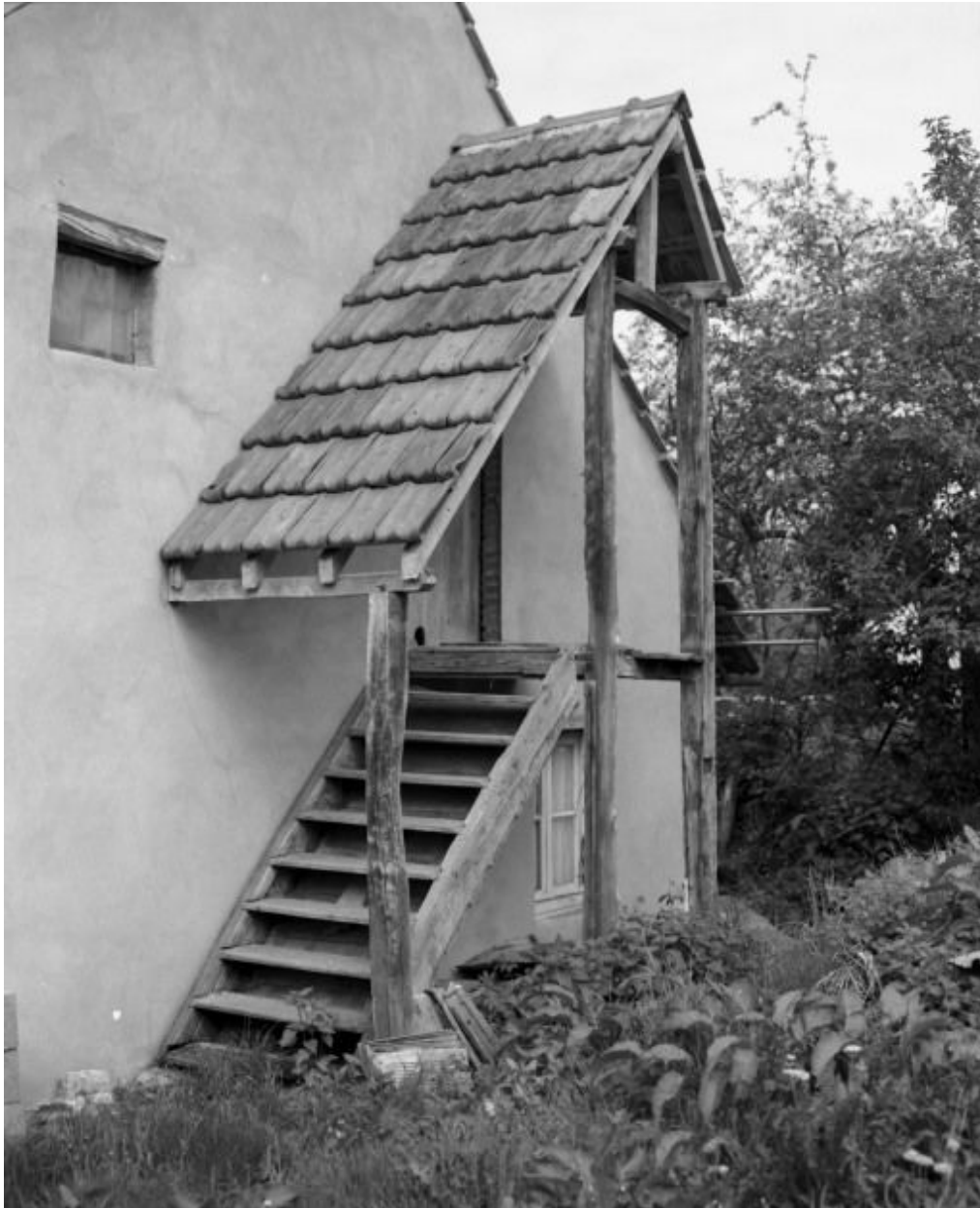
Escalier d'accès au comble.
