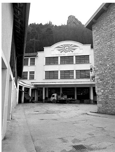
L'atelier de fabrication depuis l'entrée. Phot. Yves Sancey IVR43_19973900477X
