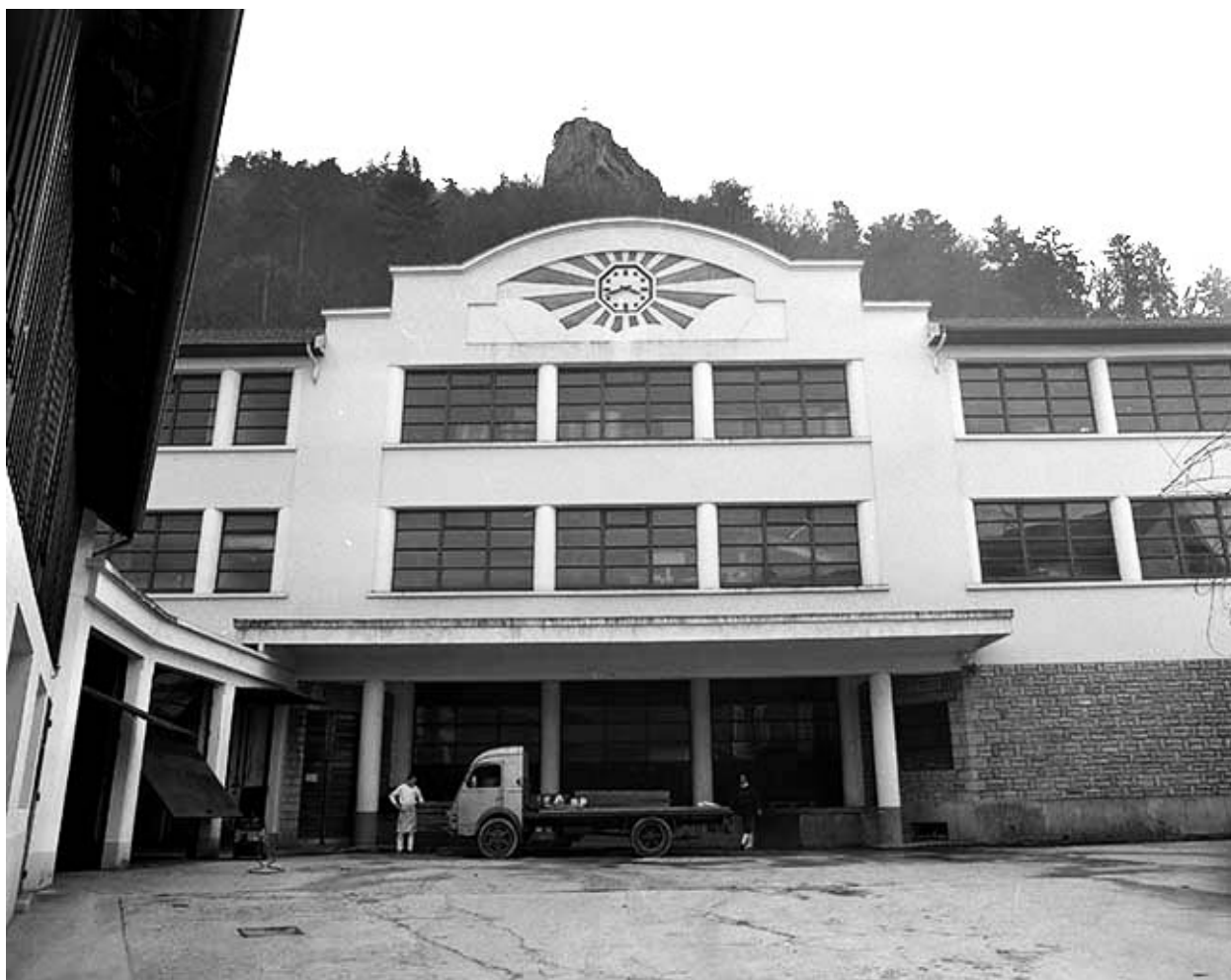
Atelier de fabrication : fronton de la façade.
