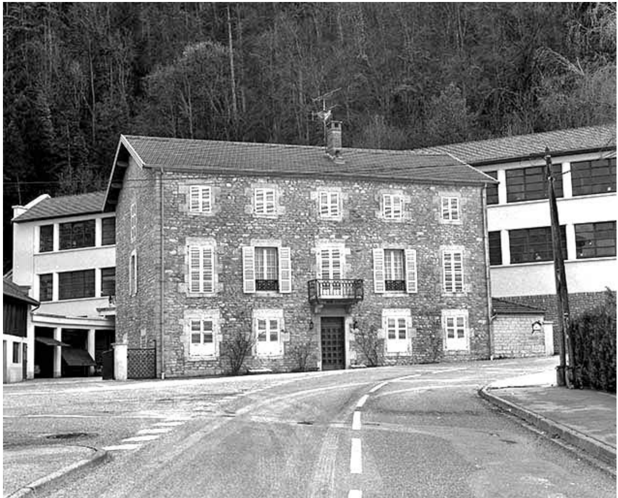
Façade antérieure du logement patronal.
