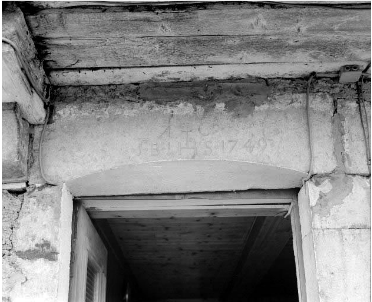
Ferme 2 : linteau de la porte d'entrée.
