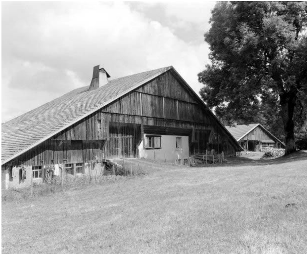
Fermes 1 et 2 : façades postérieures.
