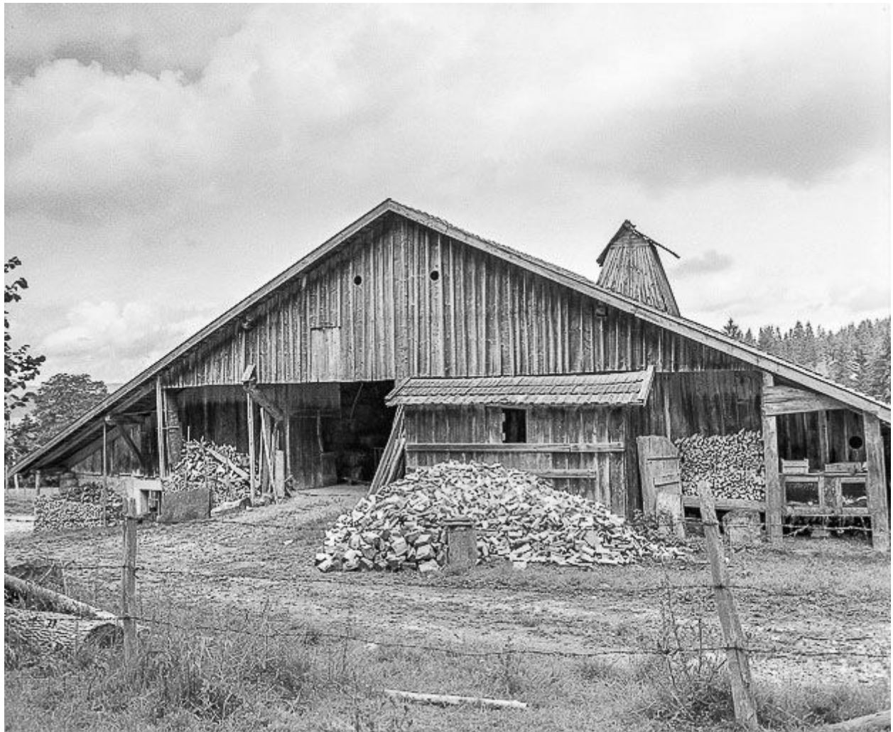
Ferme 2 : façade postérieure.
