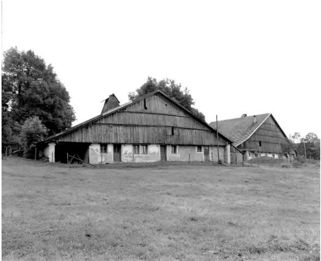
Fermes 1 et 2 : façades antérieures.
