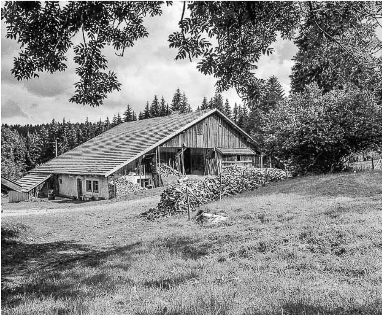
Ferme 1 : façade postérieure.
