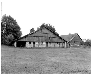
Fermes 1 et 2 : façades antérieures. Phot. Yves Sancey IVR43_19772500407X
