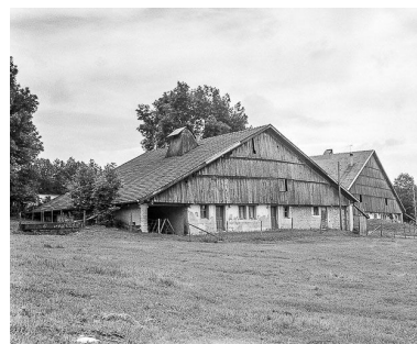
Fermes 1 et 2 : façades antérieures. Phot. Yves Sancey IVR43_19772500408X
