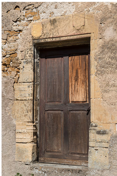
Porte latérale, façade sud. Phot. Jérôme Mongreville IVR43_20177001209NUC4A
