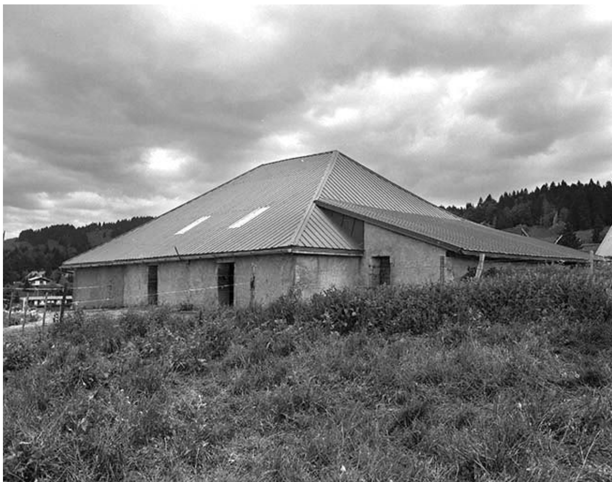
Façade postérieure vue de trois quarts droit.
