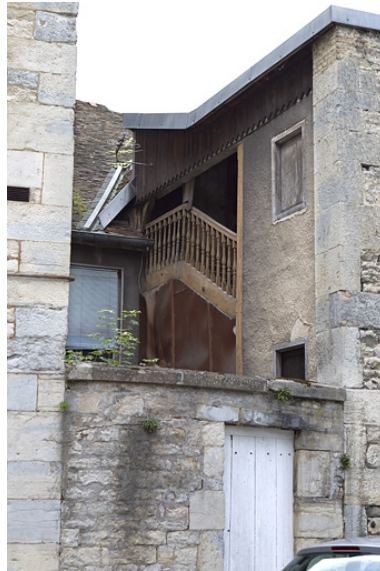
Détail de l'escalier à cage ouverte depuis la cour de l'hôtel Alviset. Phot. Yves Sancey IVR43_20102500791NUC2A
