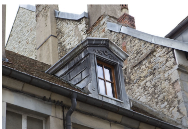
Détail de la fenêtre du comble.
