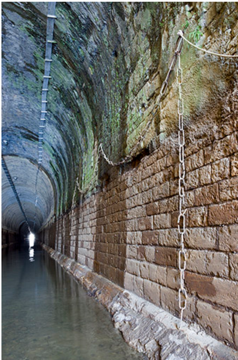
Mur latéral du tunnel maçonné.
