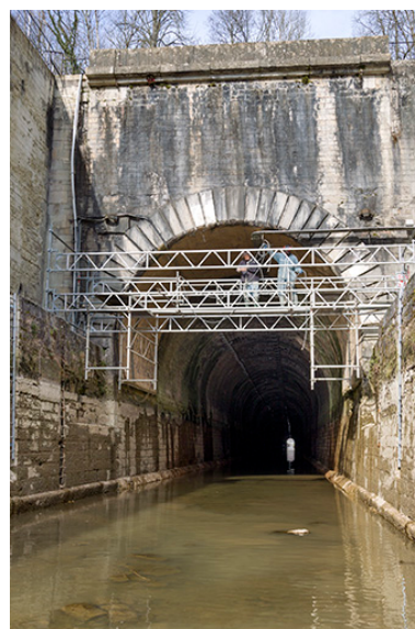
Entrée aval (restauration de la maçonnerie 2015). Phot. Sonia Dourlot IVR43_20157000258NUC2A
