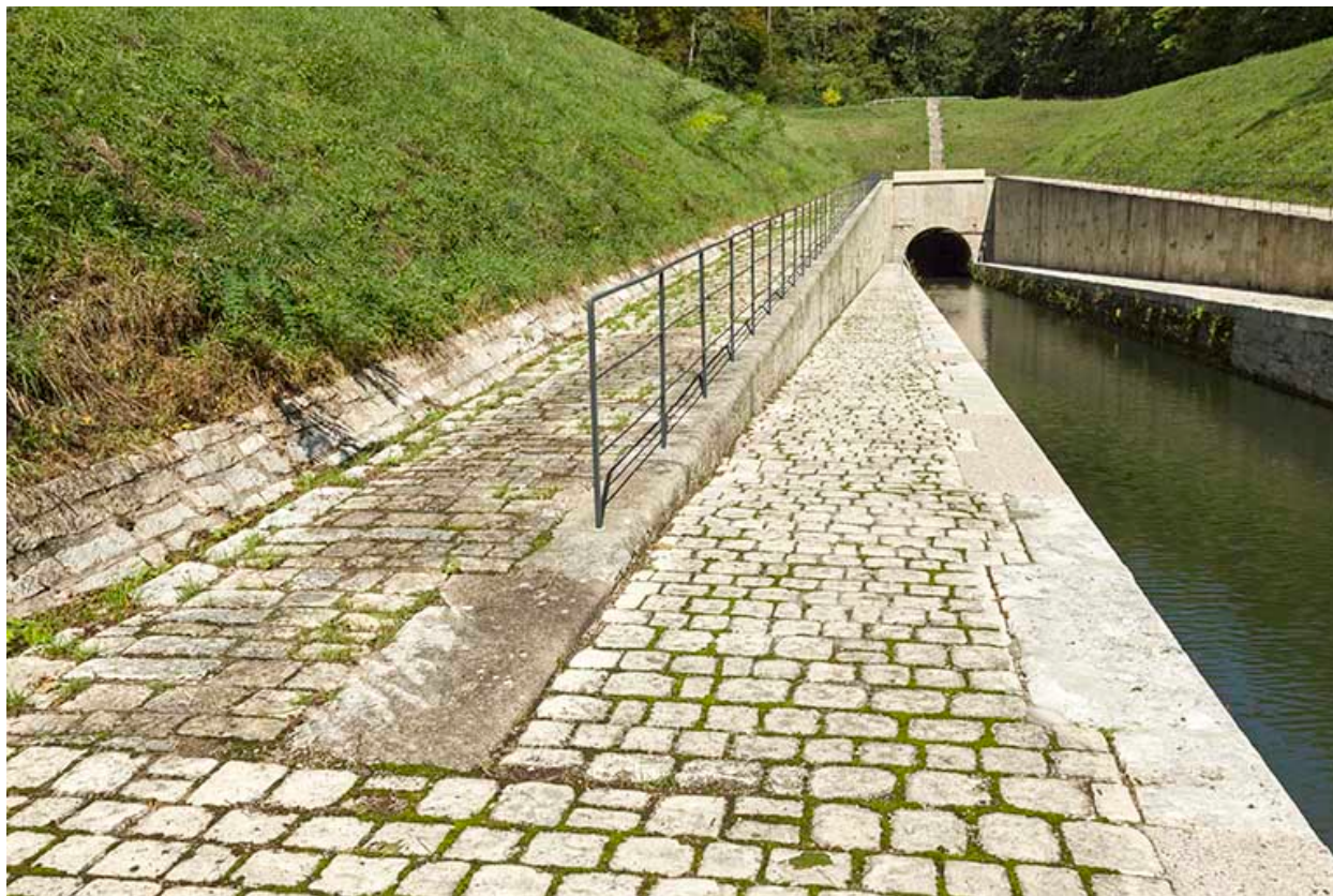
Pavage du chemin de halage.
