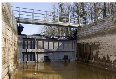
La porte de garde et le batardeau métallique. Phot. Sonia Dourlot IVR43_20157000239NUC2A
