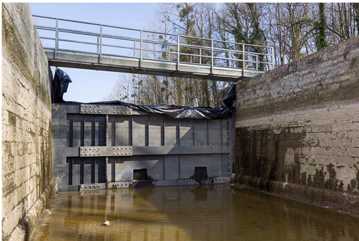
La porte de garde et le batardeau métallique.
