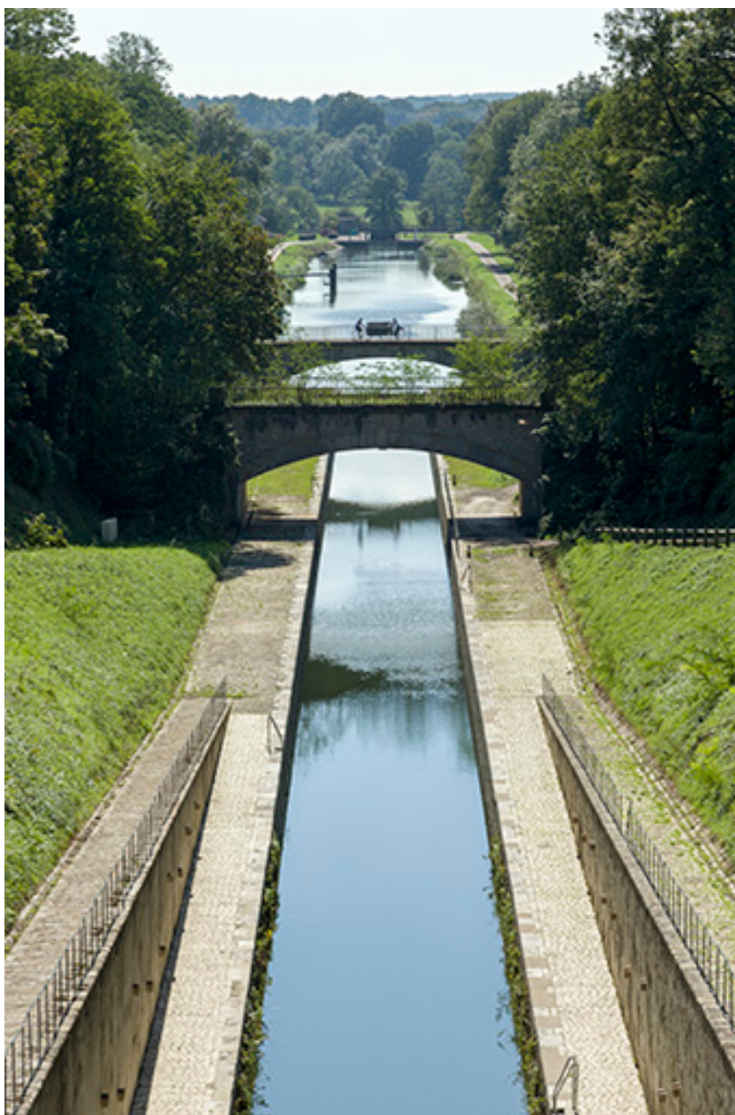
Vue aval, en direction de l'écluse.
