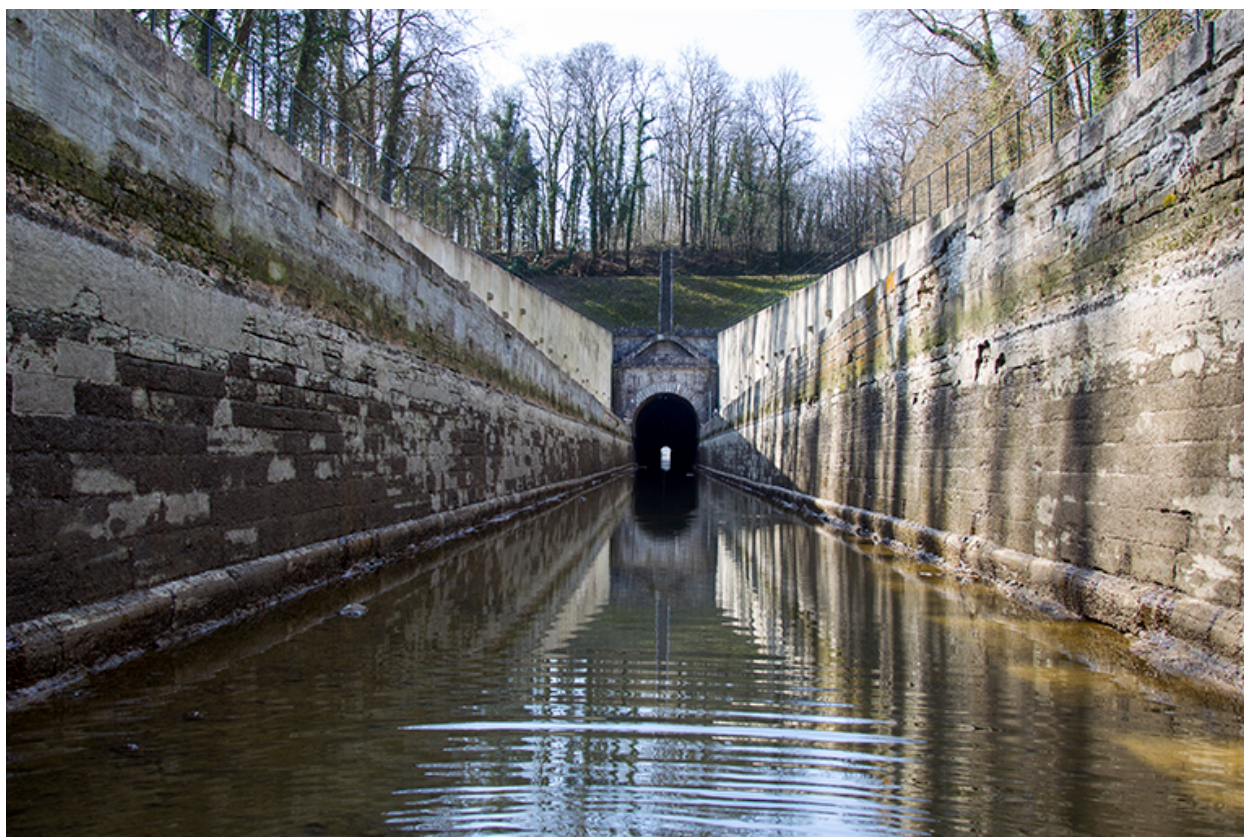
Le souterrain depuis la cuvette du canal.
