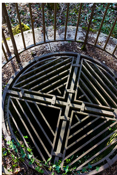
Grille de protection posée sur la margelle. Phot. Sonia Dourlot IVR43_20157000264NUC2A
