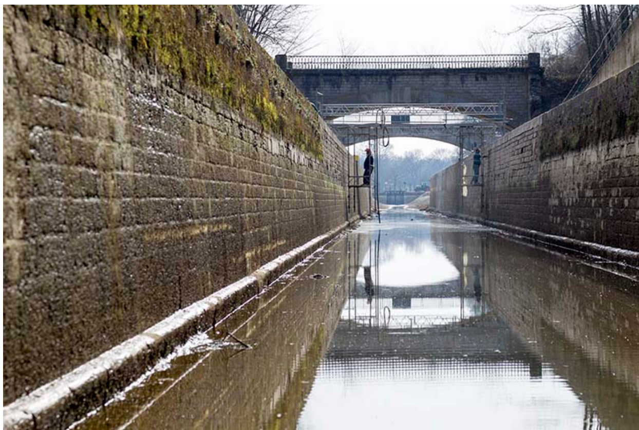
Travaux de restauration de maçonnerie en 2015.
