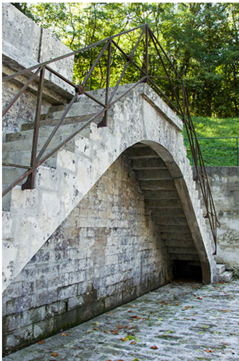
Escalier double, terrasse surplombant l'entrée du souterrain.
