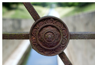
Détail, garde-corps de l'escalier. Phot. Sonia Dourlot IVR43_20157001011NUC2A
