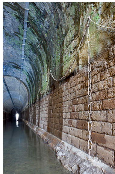
Mur latéral du tunnel maçonné. Phot. Sonia Dourlot IVR43_20157000247NUC2A
