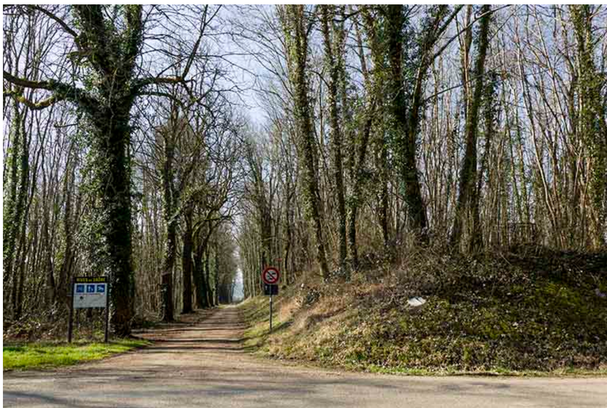
Remblai au dessus de l'ouvrage.
