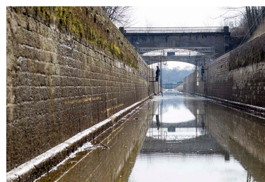
Travaux de restauration de maçonnerie en 2015. Phot. Sonia Dourlot IVR43_20157000260NUC2A
