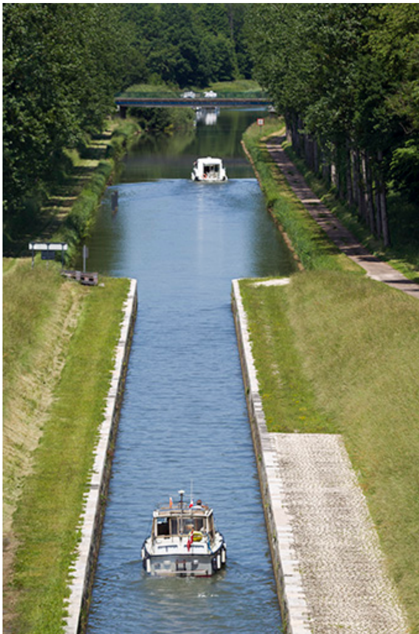
Vue amont du canal de navigation.
