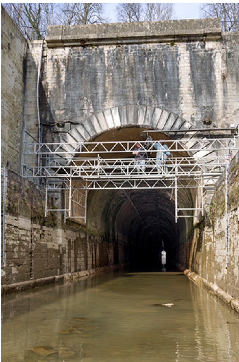
Entrée aval (restauration de la maçonnerie 2015).
