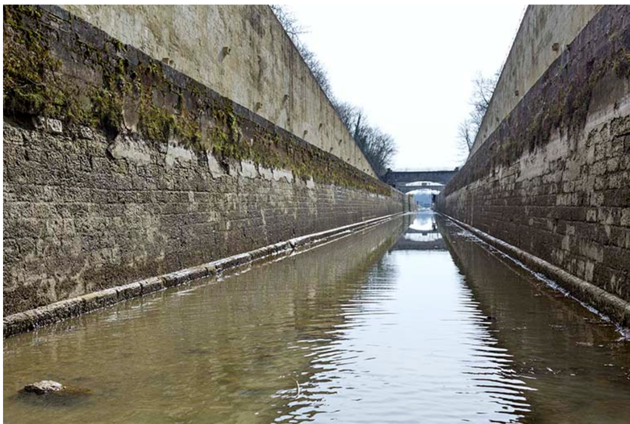
Le canal, vue prise depuis le radier.
