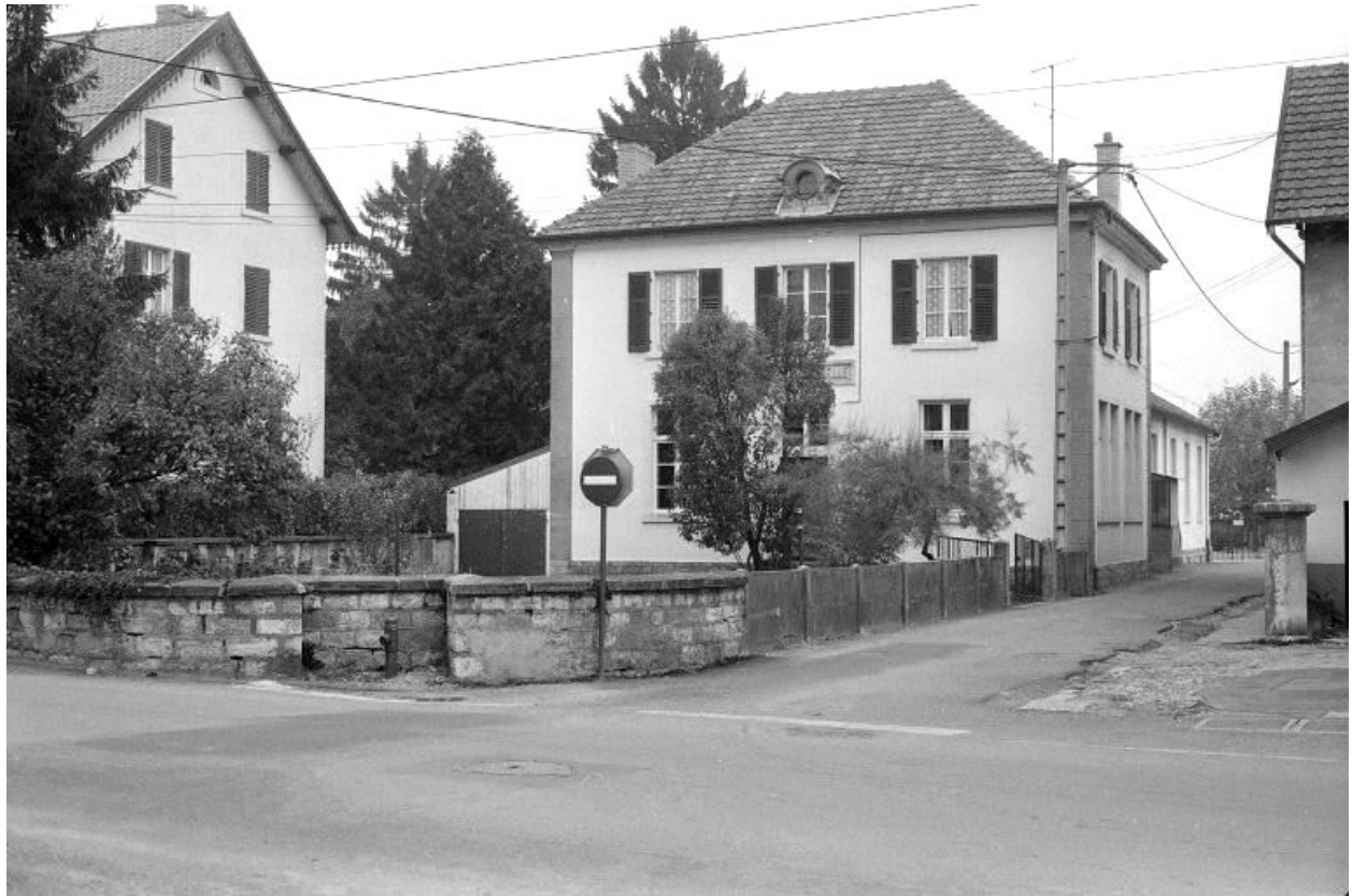
Ecole située avenue de la Gare.
