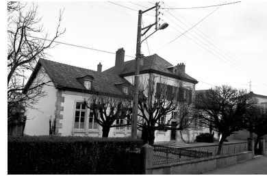
Ecole située rue Renaud. Phot. Bernard Lardière IVR43_19832500144Z
