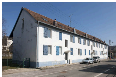
Immeuble de 12 logements vu depuis l'ouest. Phot. Jérôme Mongreville IVR43_20122500161NUC4A
