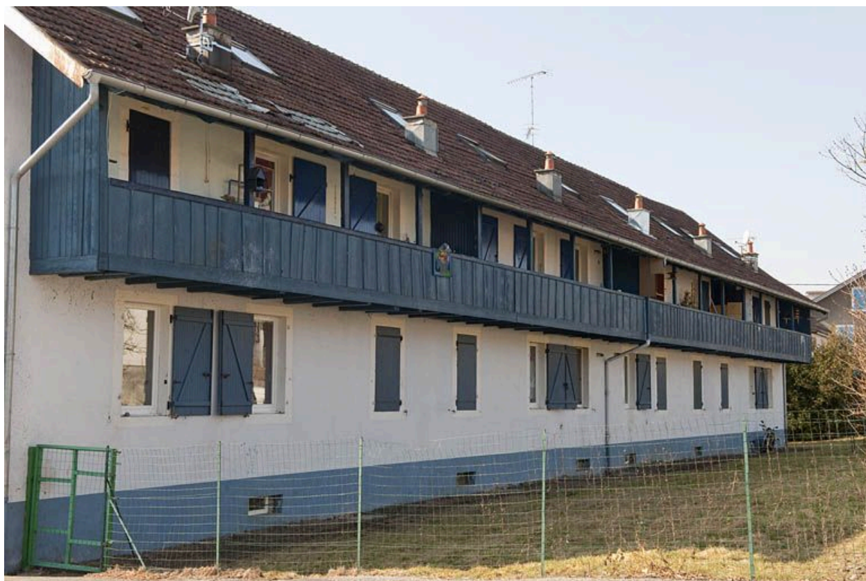
Immeuble de 12 logements. Façade postérieure.
