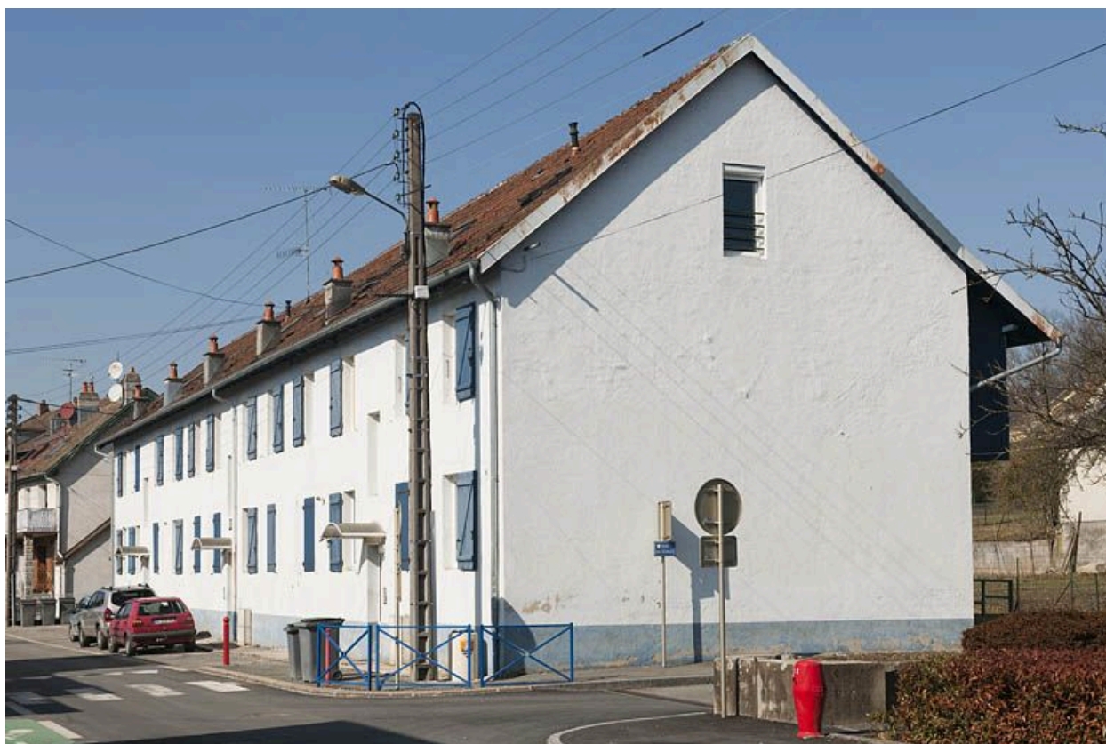
Immeuble de 12 logements vu depuis le sud-est.
