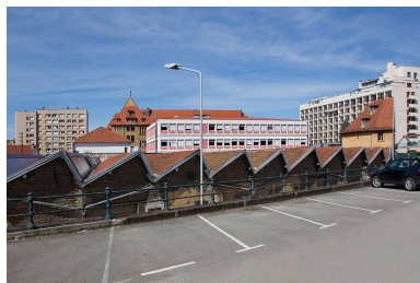
Atelier de fabrication boulevard Diderot : vue d'ensemble depuis l'est. Phot. Yves Sancey IVR43_20112502330NUC2A
