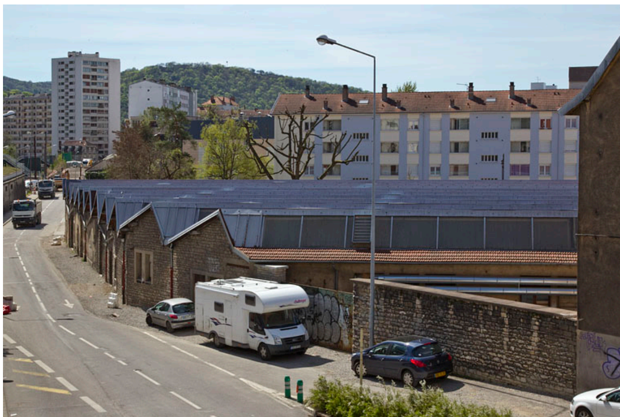
Atelier de fabrication boulevard Diderot : vue depuis le nord.
