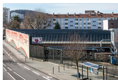
Atelier de l'usine automobile, depuis le nord. Phot. Jérôme Mongreville IVR43_20182500571NUC4A
