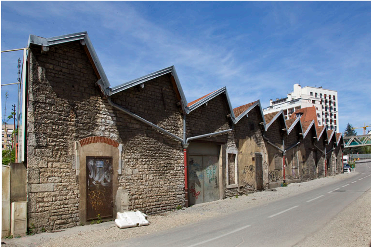
Atelier de fabrication boulevard Diderot : pignons des sheds.
