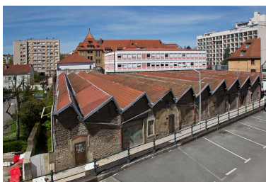
Atelier de fabrication boulevard Diderot : vue d'ensemble plongeante, depuis l'est. Phot. Yves Sancey IVR43_20112502332NUC2A
