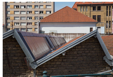
Atelier de fabrication boulevard Diderot : détail des sheds. Phot. Yves Sancey IVR43_20112502331NUC2A
