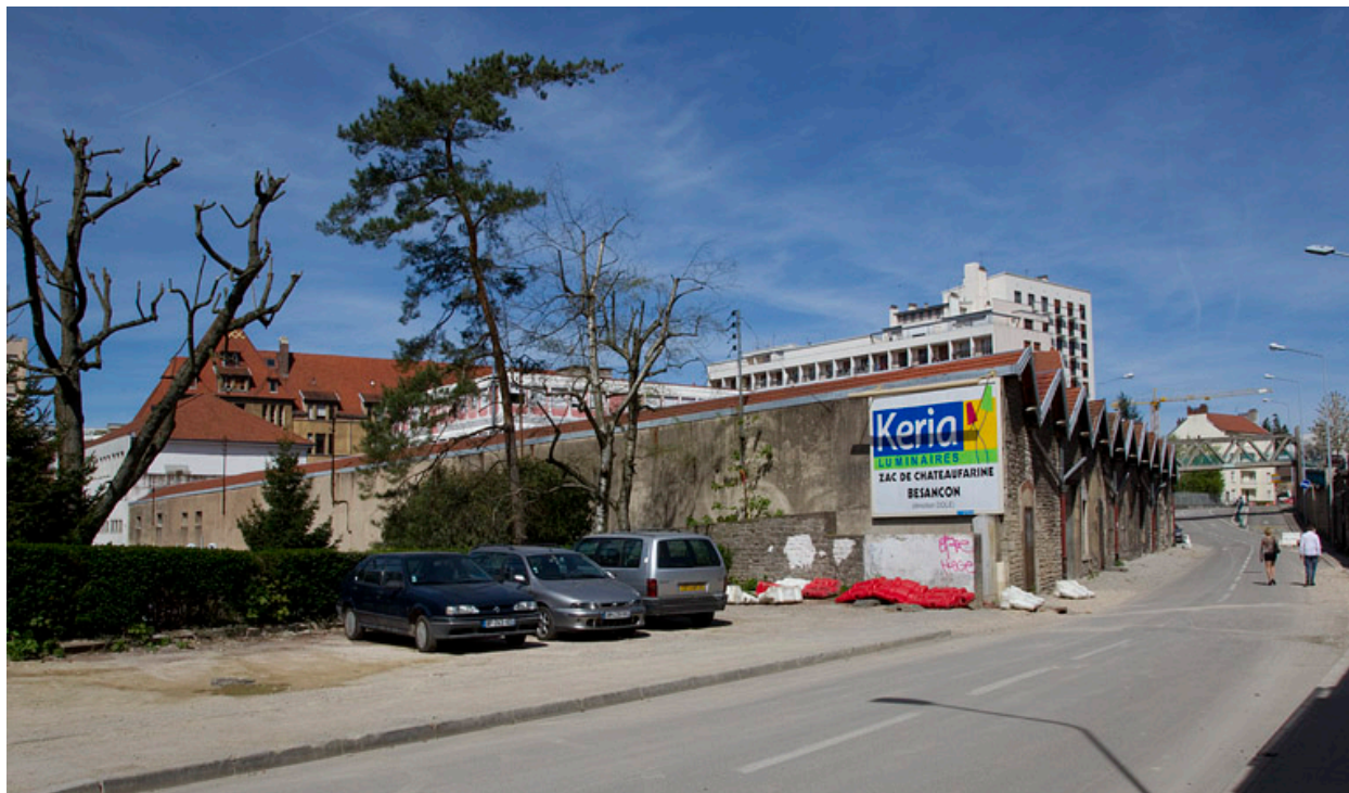
Atelier de fabrication boulevard Diderot : vue d'ensemble depuis le sud.
