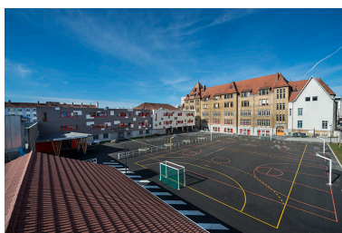
Vue d'ensemble des bâtiments du lycée depuis l'est. Phot. Jérôme Mongreville IVR43_20182500570NUC4A
