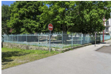
Clôture encore en place, vue depuis le boulevard Richet. Phot. Fabien Dufoulon IVR43_20217000444NUC2A
