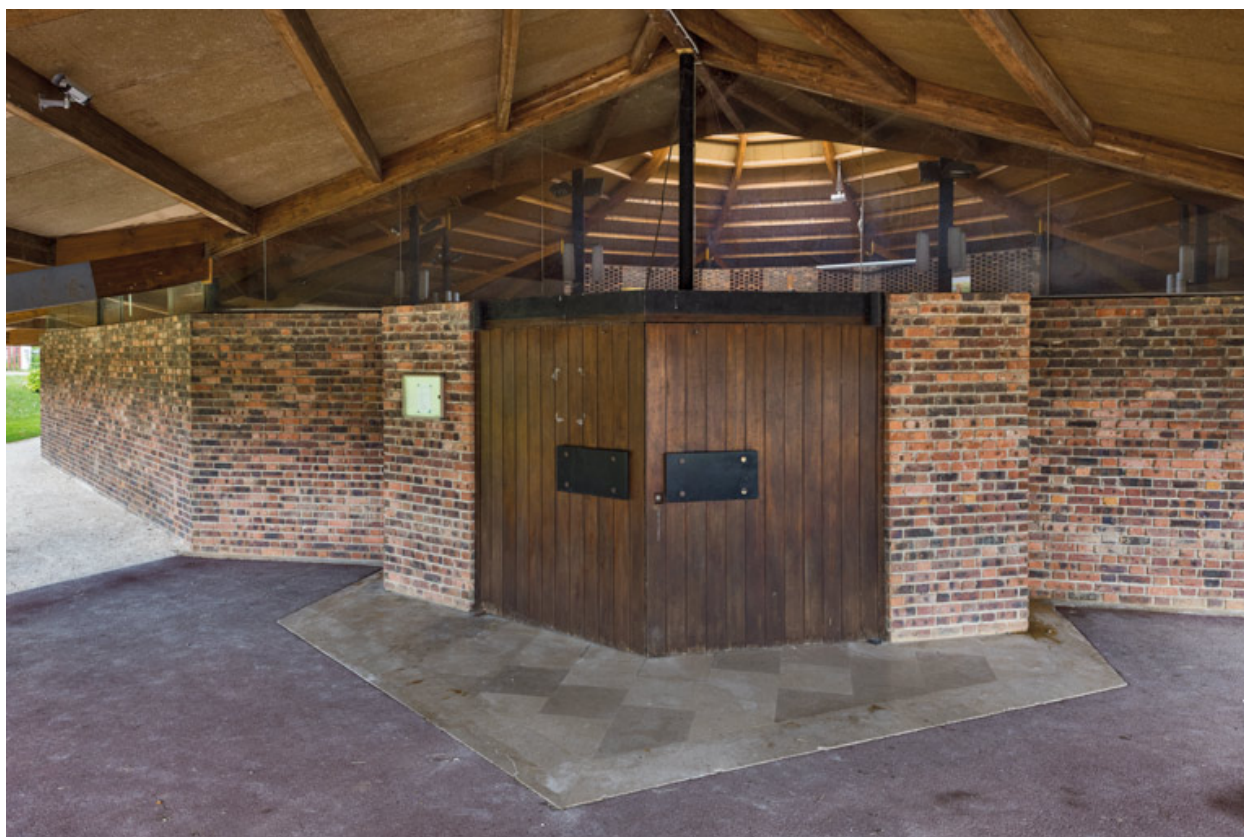
Eglise. Détail de l'entrée principale.
