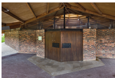
Eglise. Détail de l'entrée principale. Phot. Pierre-Marie Barbe-Richaud IVR26_20258900088NUC4A
