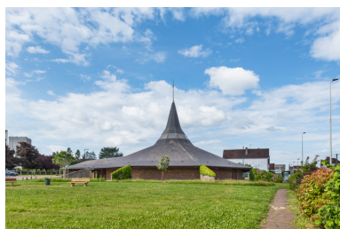
Vue rapprochée depuis le sud. Phot. Pierre-Marie Barbe-Richaud IVR26_20258900087NUC4A
