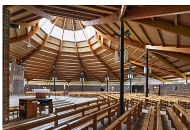
La nef. Vue depuis le nord-ouest, en direction de l'entrée principale. Phot. Pierre-Marie Barbe-Richaud IVR26_20248900314NUC4A
