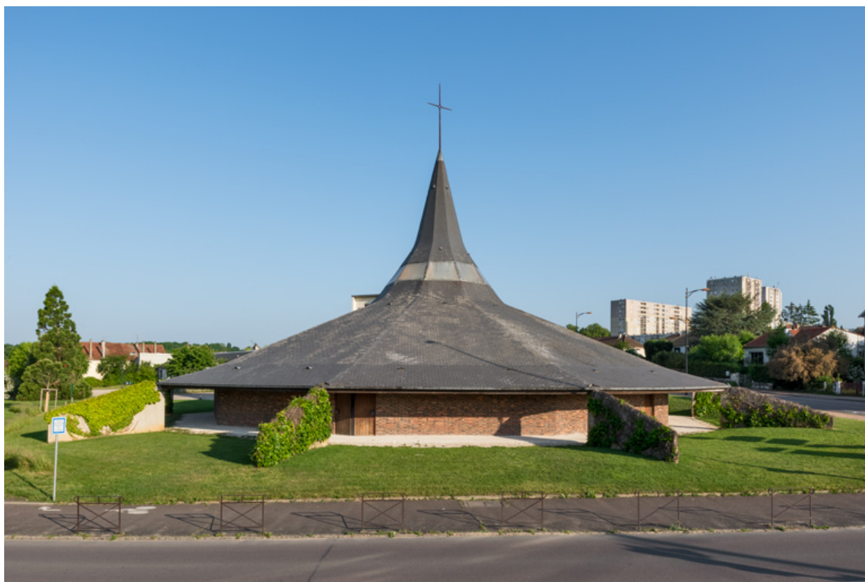
Vue depuis le sud-ouest.
