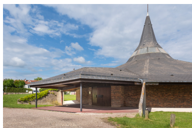
Porche de l'église. Vue de trois quarts. Phot. Pierre-Marie Barbe-Richaud IVR26_20258900085NUC4A
