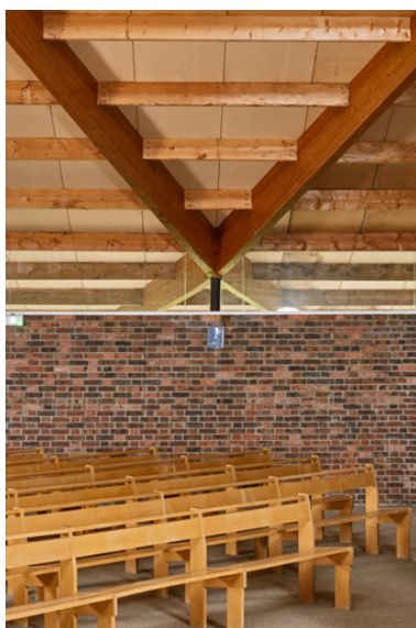
Charpente et pilier métallique intégré dans le mur. Détail. Phot. Pierre-Marie Barbe-Richaud IVR26_20248900317NUC4A
