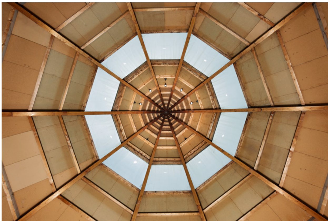
Lanternon. Vue en contre-plongée.
