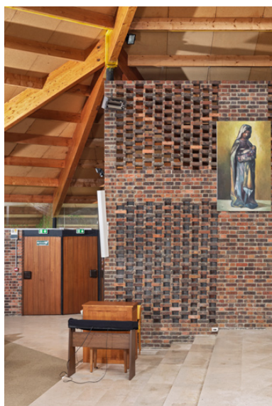
Mur du chœur. Détail.
