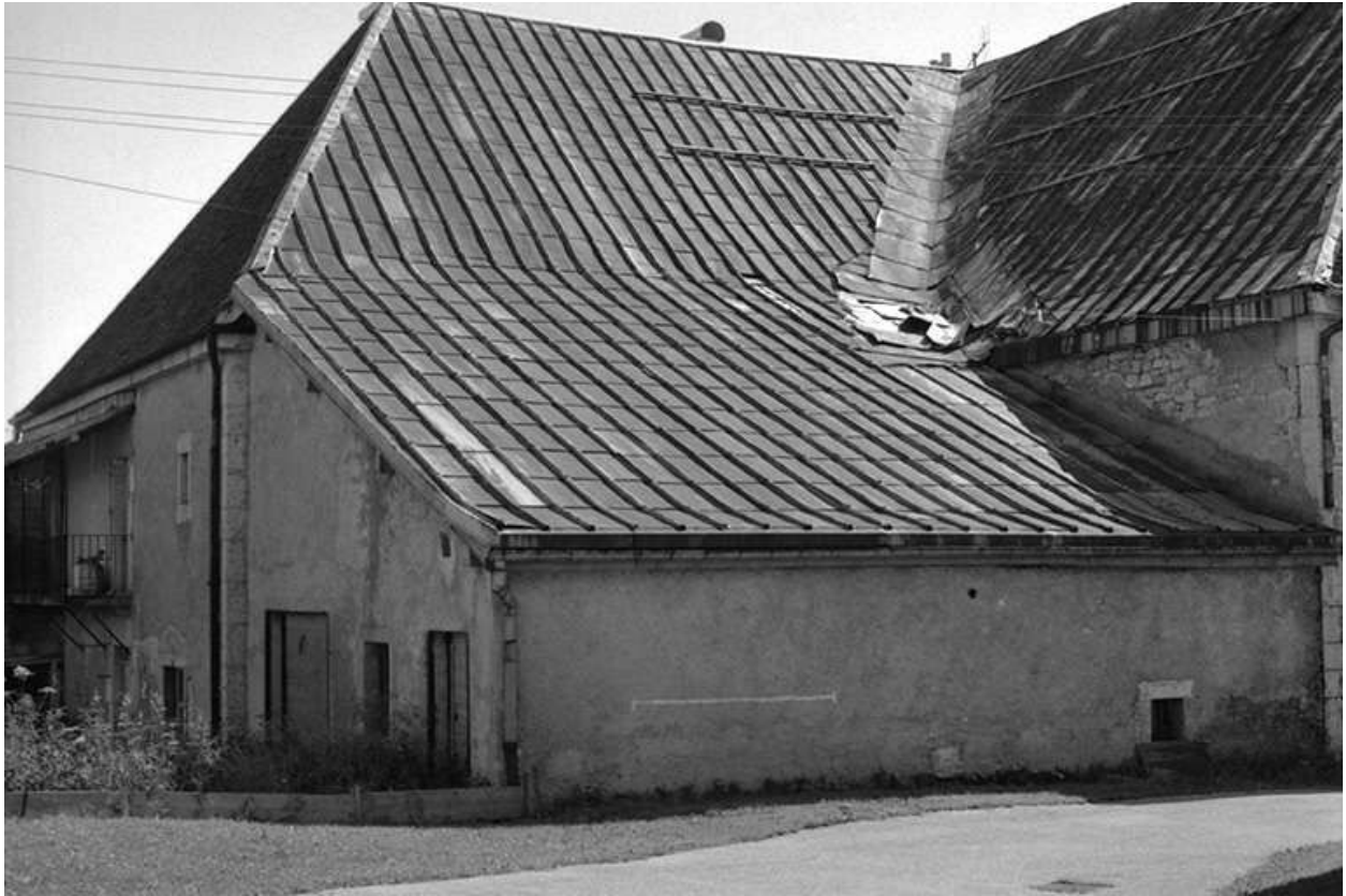
Façades postérieure et latérale droite.
