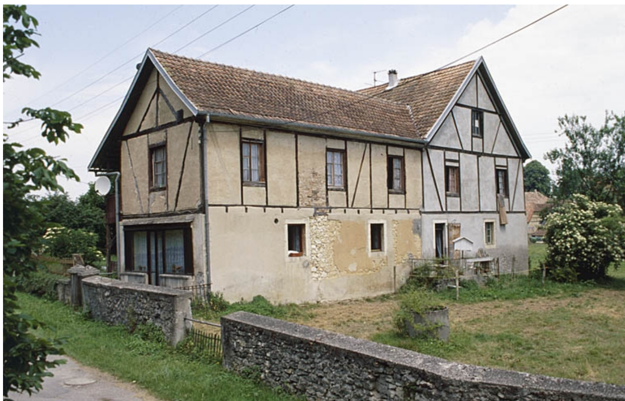
Façade postérieure du logement.
