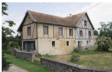
Façade postérieure du logement.
