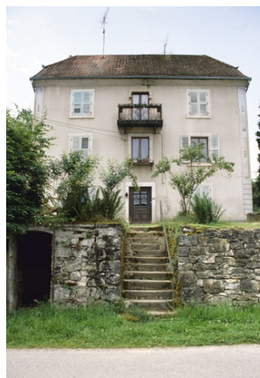
Façade antérieure du logement patronal.
