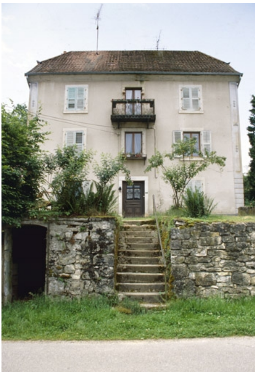
Façade antérieure du logement patronal.
