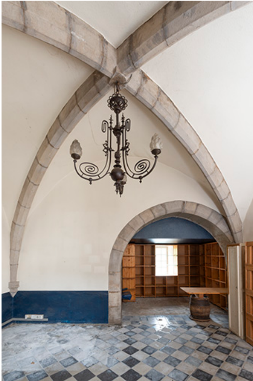
Pièce voûtée (rez-de-chaussée de la tour). Vue depuis la porte.
