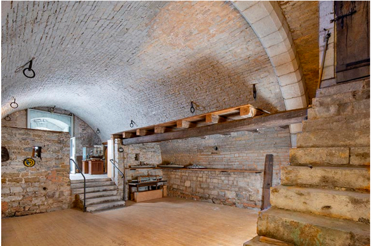
Cave est (aile nord). Vue depuis le nord-est.
