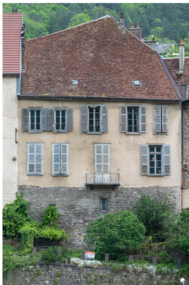
Extrémité nord de la façade occidentale. Phot. Jérôme Mongreville IVR43_20233900450NUC4A
