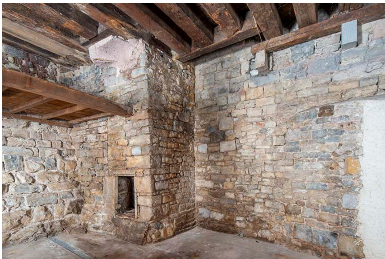
Cave ouest. Maçonneries à l'angle nord-est.
