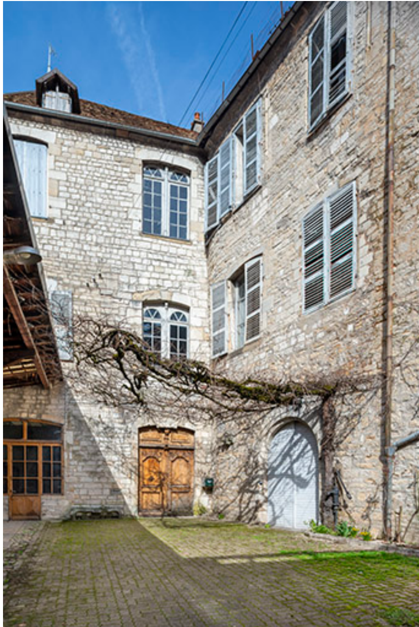
Façades est et sud depuis la cour.
