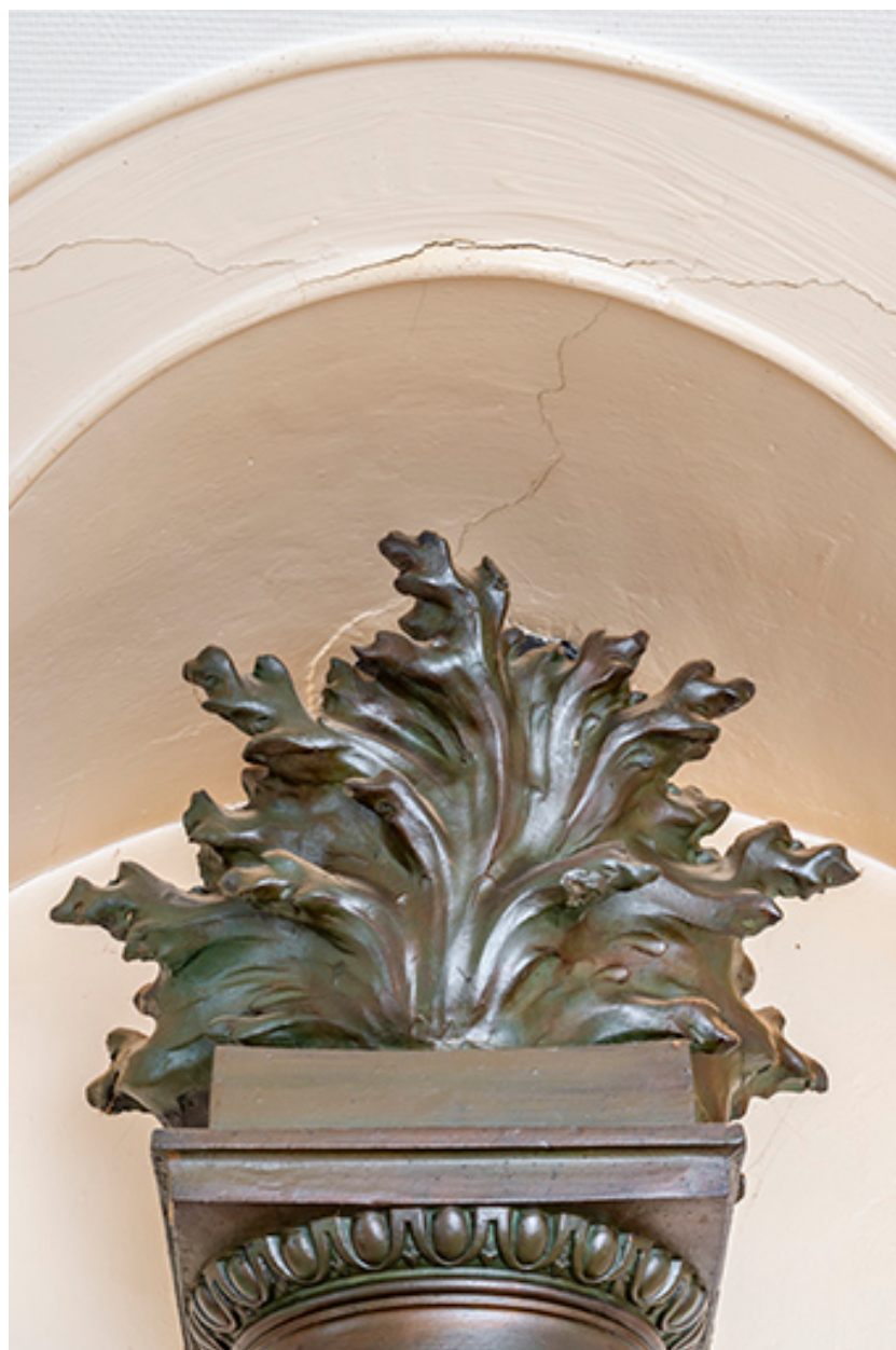
Cheminée. Couronnement du conduit d'évacuation (grès flammé).
