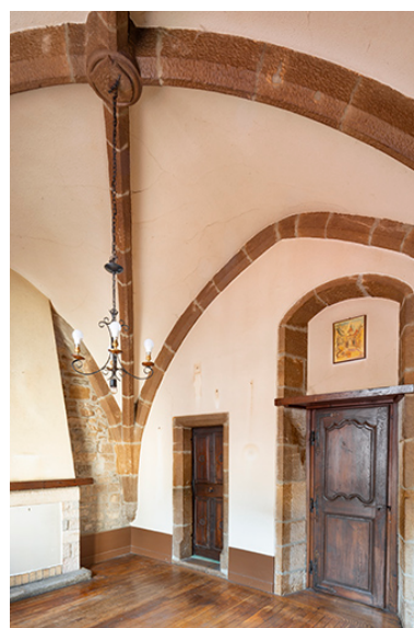
Voûtement de la pièce au premier étage. Phot. Jérôme Mongreville IVR43_20223901307NUC4A
