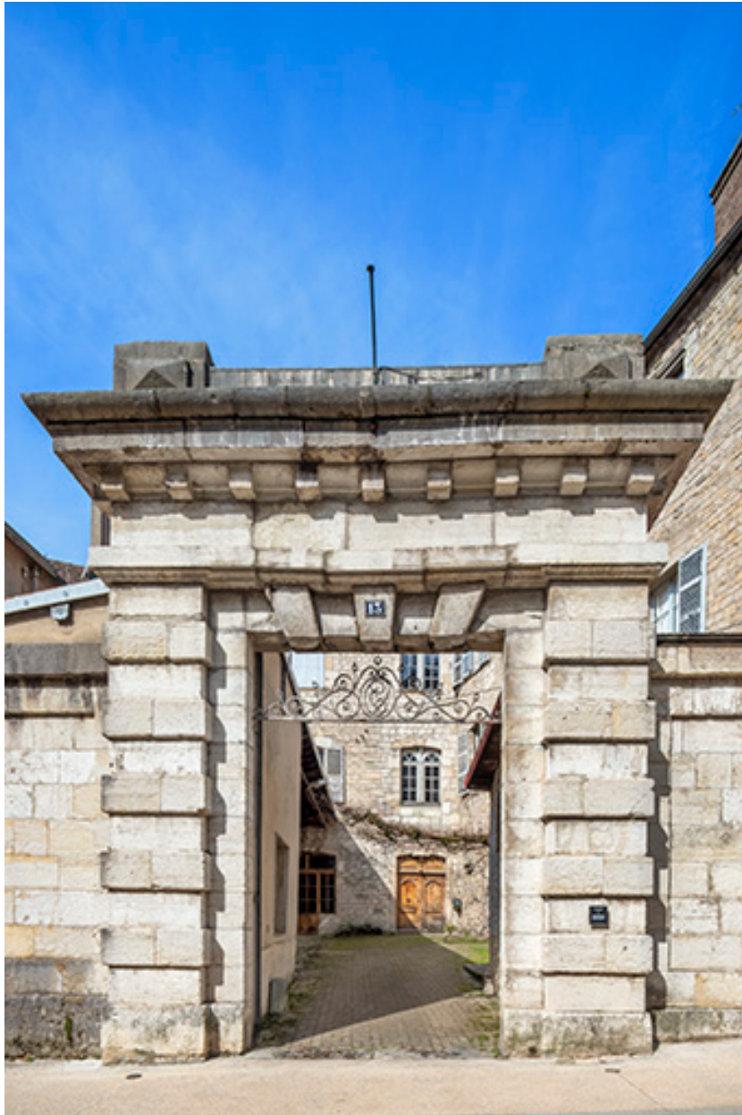
Porte monumentale de la cour.
