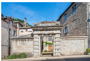
Vue de face du mur et de la porte monumentale. Phot. Jérôme Mongreville IVR43_20233900870NUC4A
