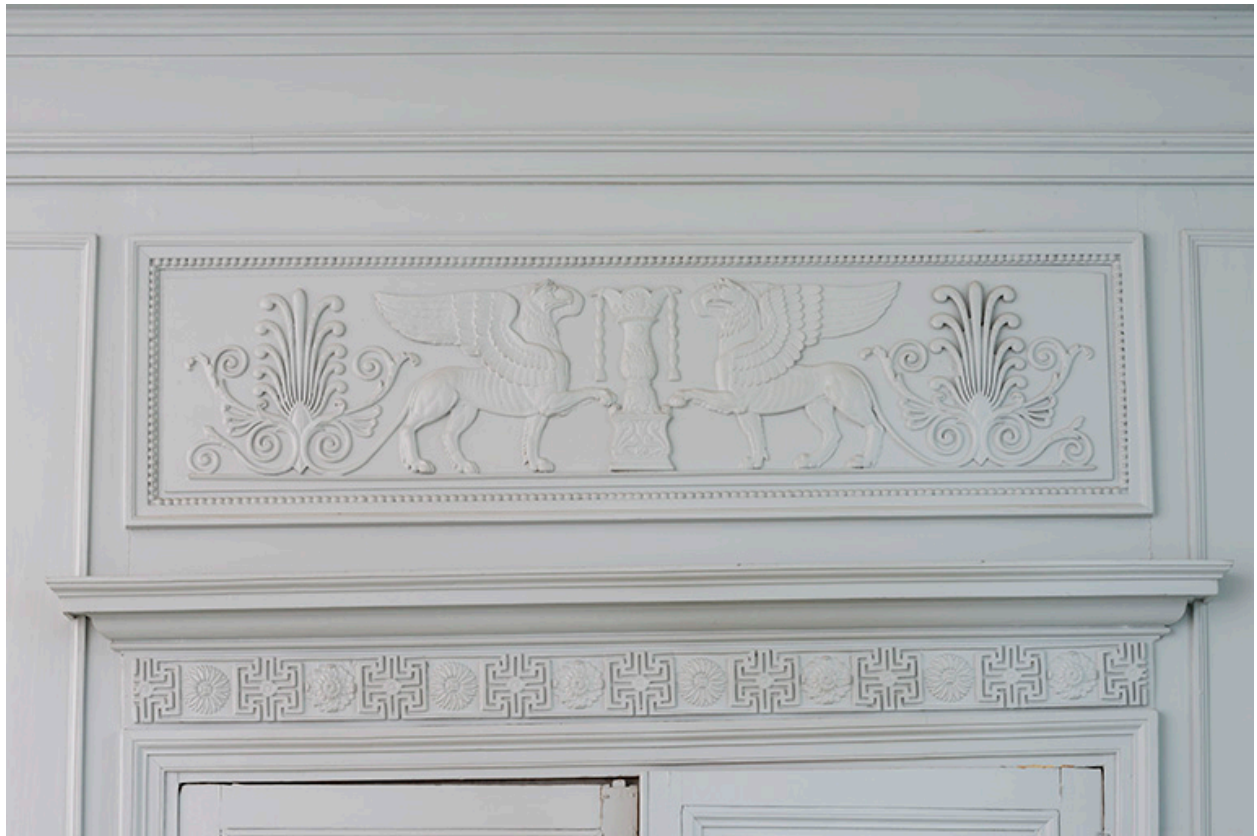
Pièce du premier étage (aile nord). Décor à motifs antiques.
