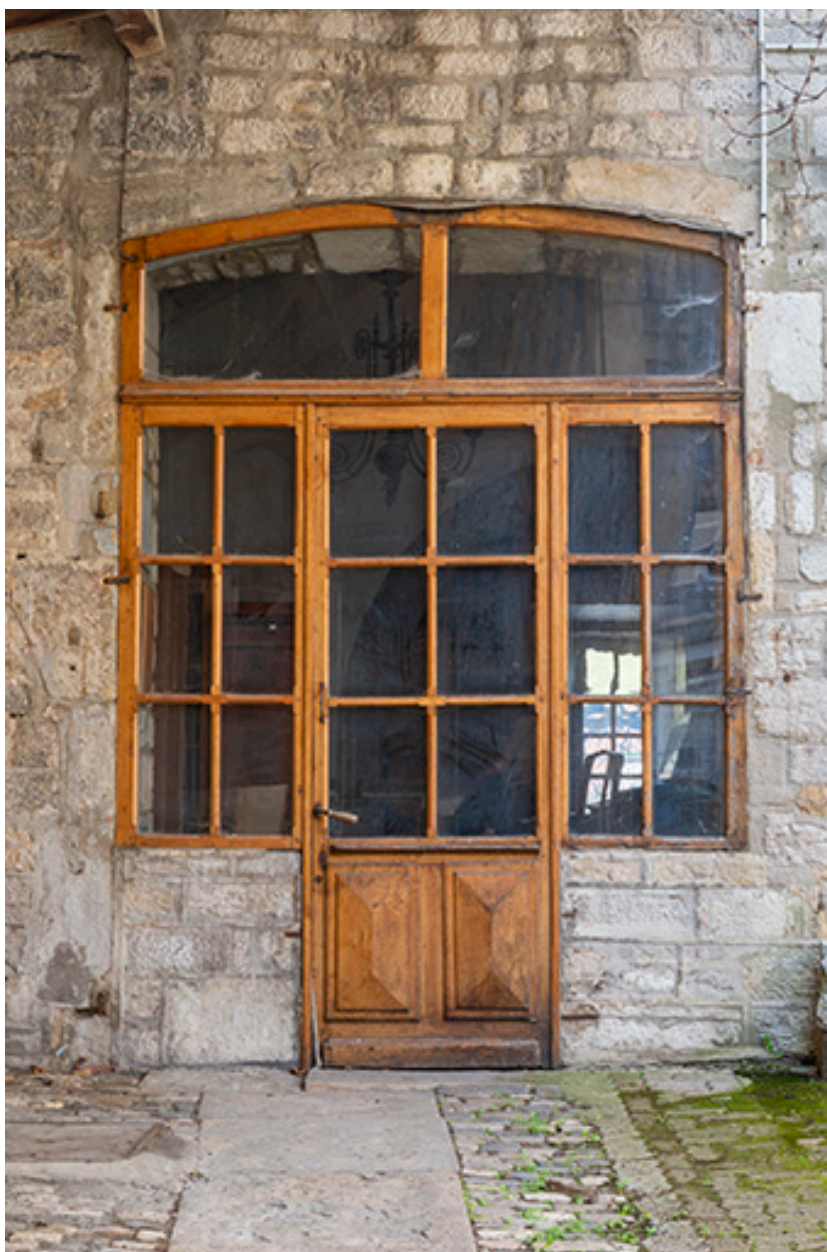
Porte gauche sur cour (mur est).
