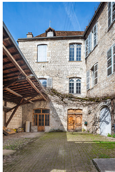
Vue depuis la porte de la cour. Phot. Jérôme Mongreville IVR43_20233900095NUC4A
