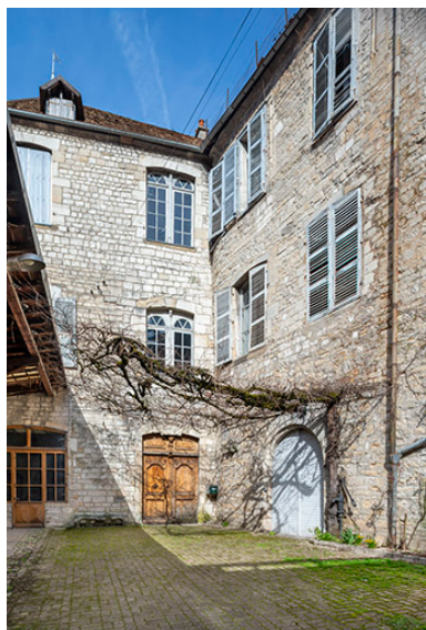
Façades est et sud depuis la cour. Phot. Jérôme Mongreville IVR43_20233900096NUC4A
