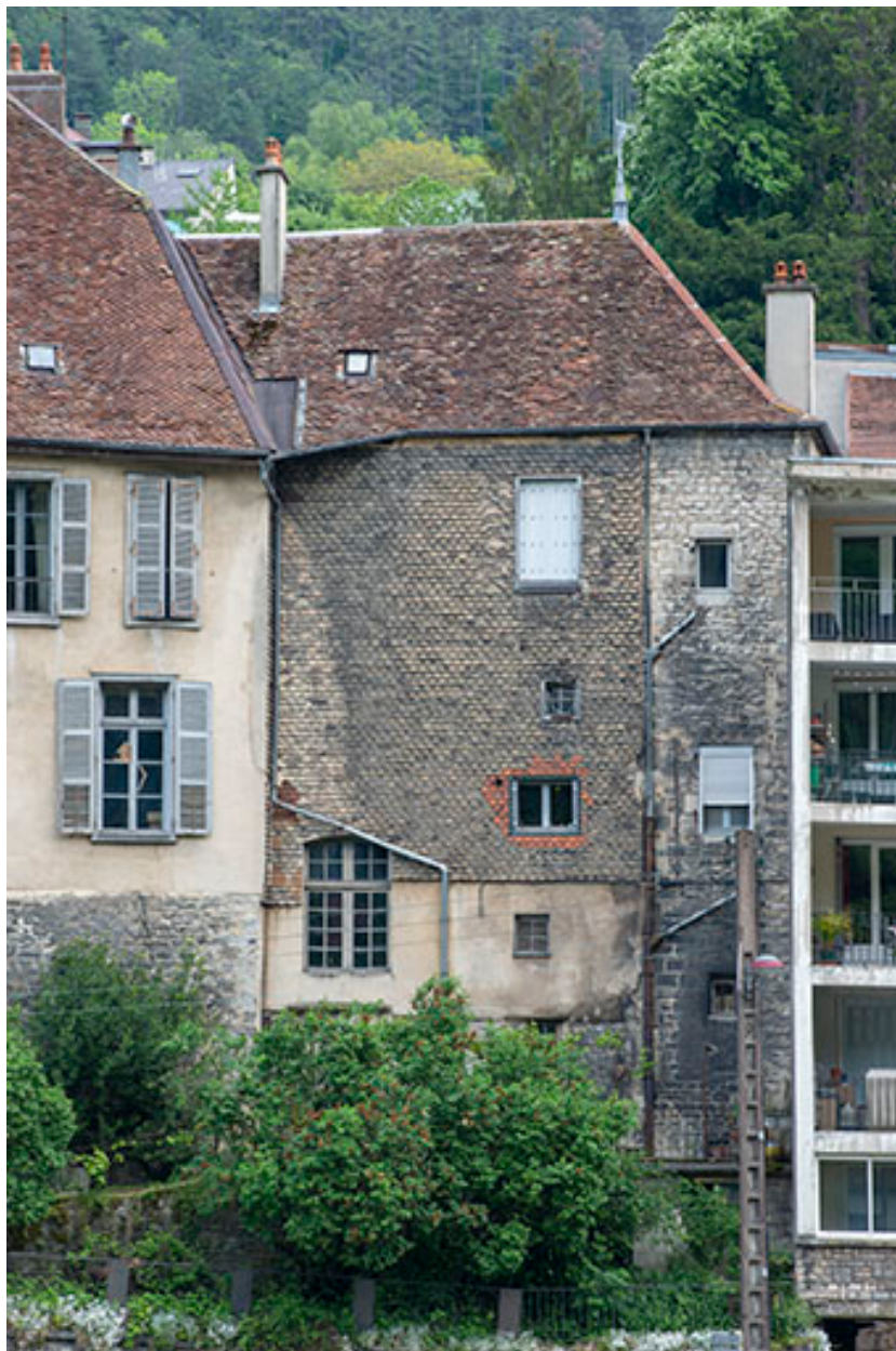
Extrémité sud de la façade occidentale.
