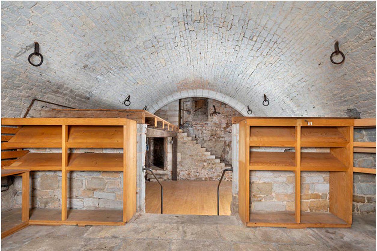
Cave (aile nord). Vue depuis l'entrée.
