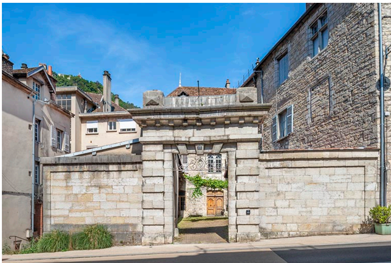
Vue de face du mur et de la porte monumentale.
