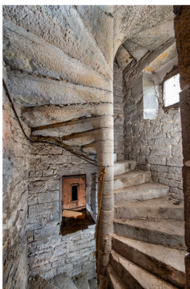
Escalier en vis de la tour. Phot. Jérôme Mongreville IVR43_20223901306NUC4A
