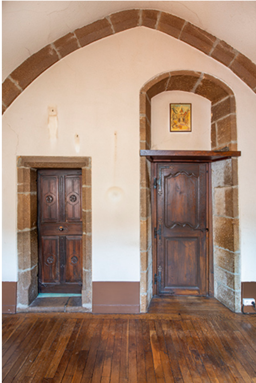
Pièce du premier étage. Mur ouest.
