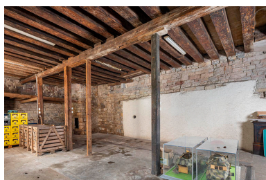
Cave ouest. Vue partielle de trois quarts. Phot. Jérôme Mongreville IVR43_20223901302NUC4A
