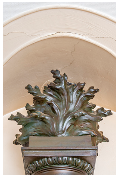
Cheminée. Couronnement du conduit d'évacuation (grès flammé). Phot. Jérôme Mongreville IVR43_20223901321NUC4A
