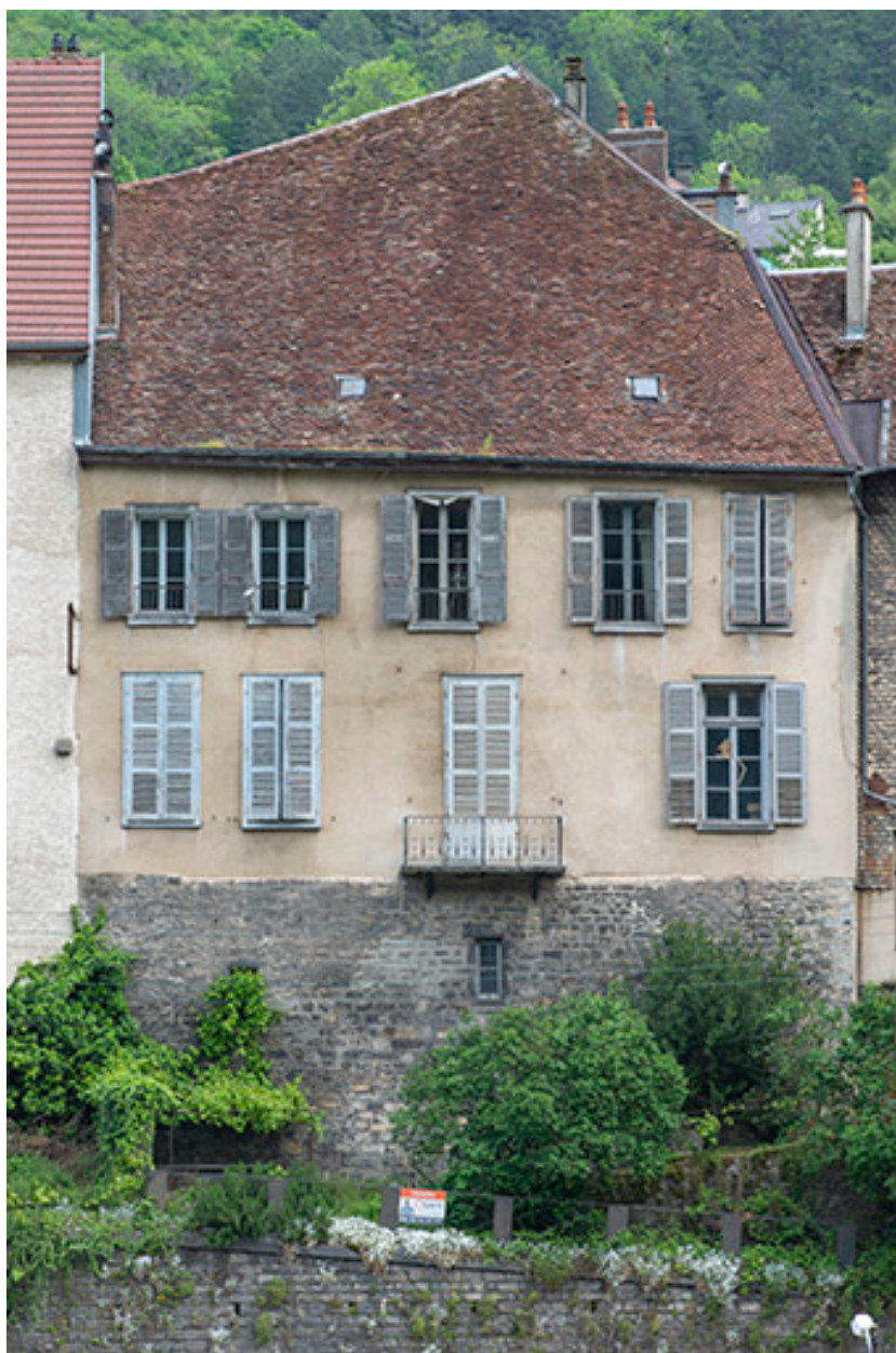
Extrémité nord de la façade occidentale.
