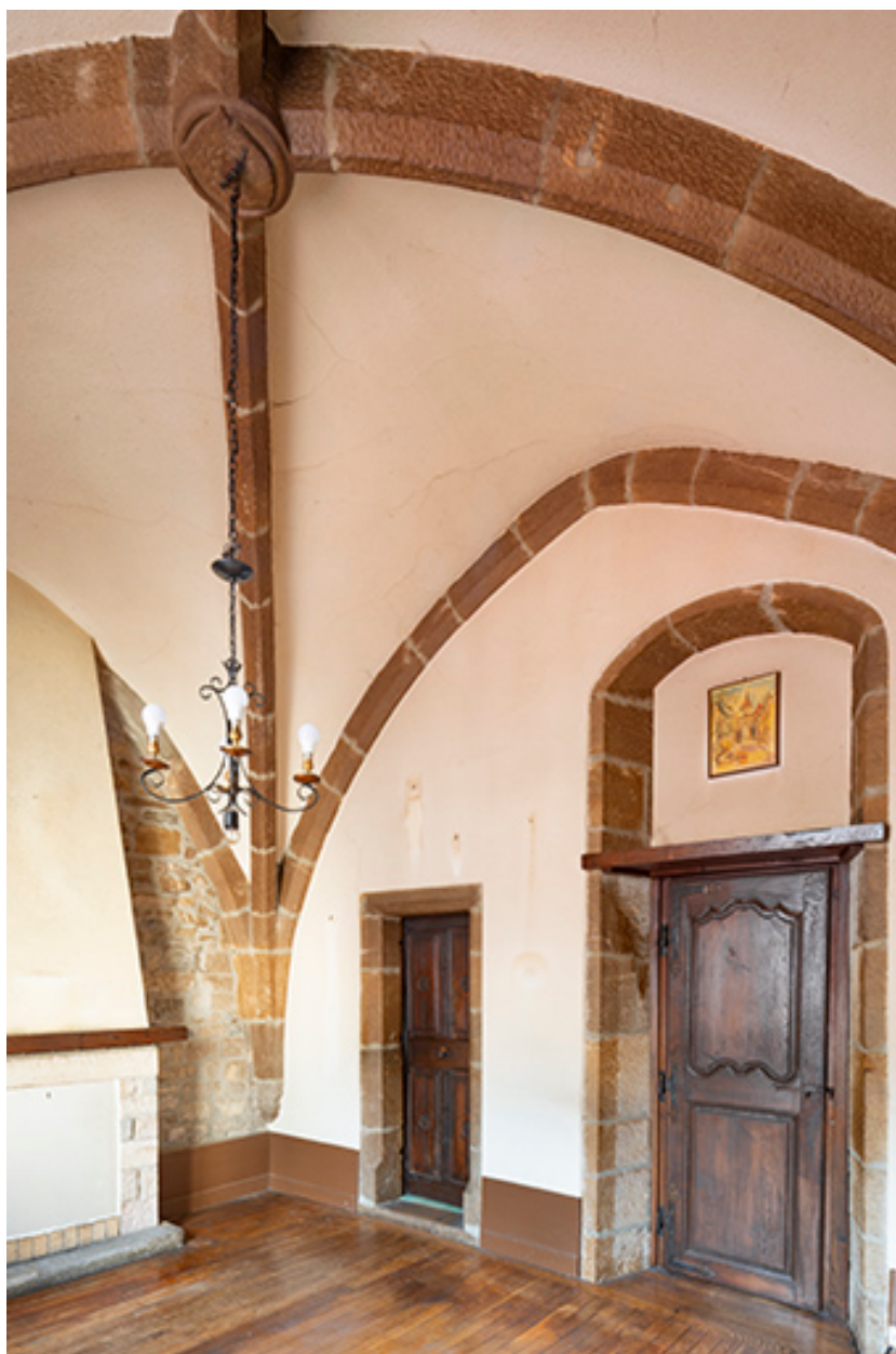
Voûtement de la pièce au premier étage.
