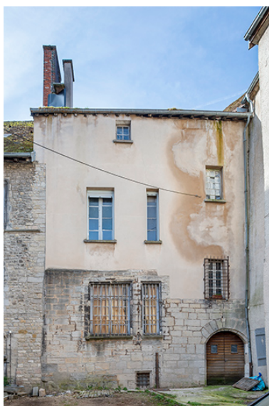
Aile nord (vue depuis la cour des halles). Phot. Jérôme Mongreville IVR43_20233900085NUC4A
