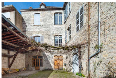
La cour vue depuis le nord-est. Phot. Jérôme Mongreville IVR43_20233900098NUC4A
