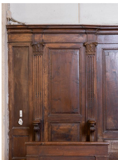
Détail des pilastres. Phot. Pierre-Marie Barbe-Richaud IVR26_20162100207NUC2A
