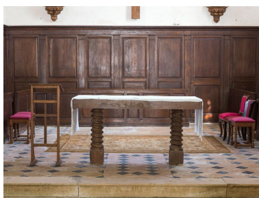
Vue d'ensemble des lambris. Phot. Pierre-Marie Barbe-Richaud IVR26_20162100212NUC2A
