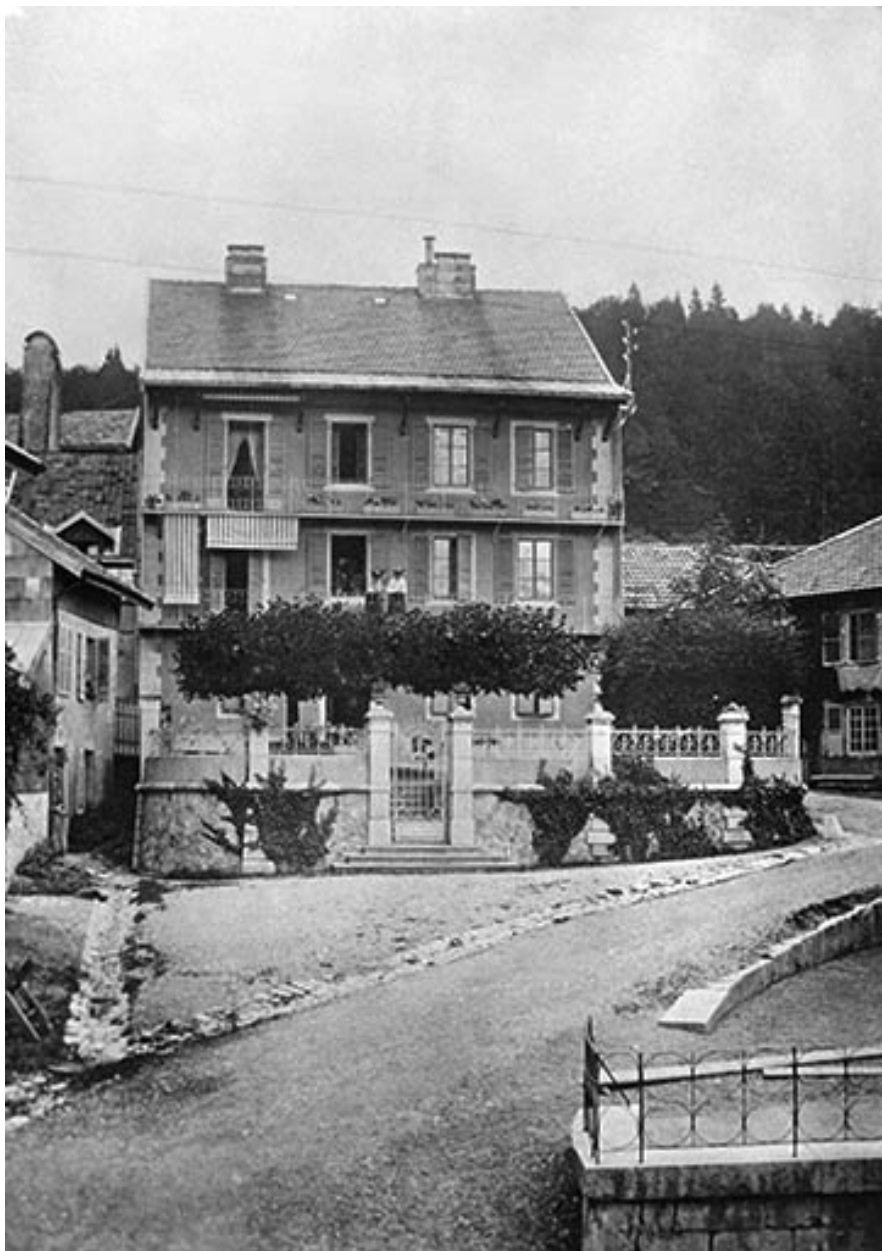
Façade antérieure du logement patronal.
