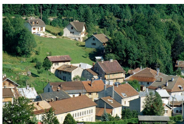
Vue d'ensemble depuis l'ouest. Phot. Laurent Poupard IVR43_19913901600ZA
