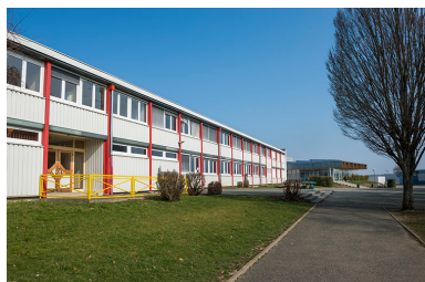
Façade sud de l'externat sud. Phot. Mary Ruffinoni IVR43_20149000104NUC4A
