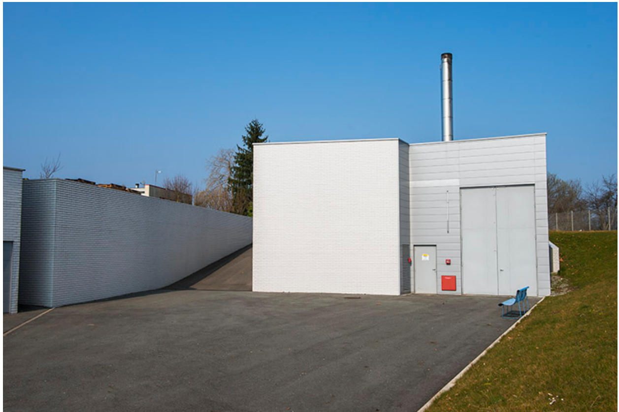
Façade postérieure sud de la chaufferie.
