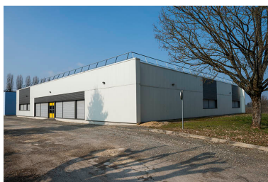
Angle sud-est des ateliers.
