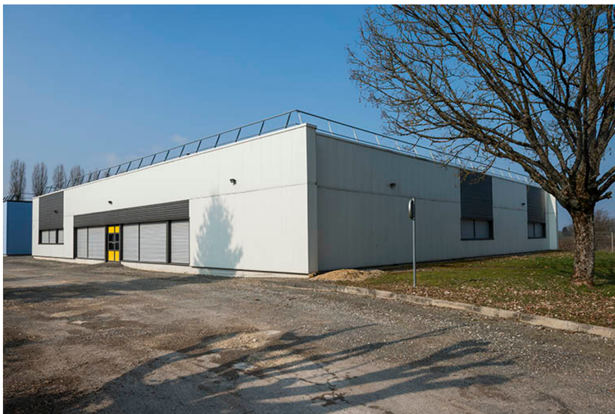
Angle sud-est des ateliers.
