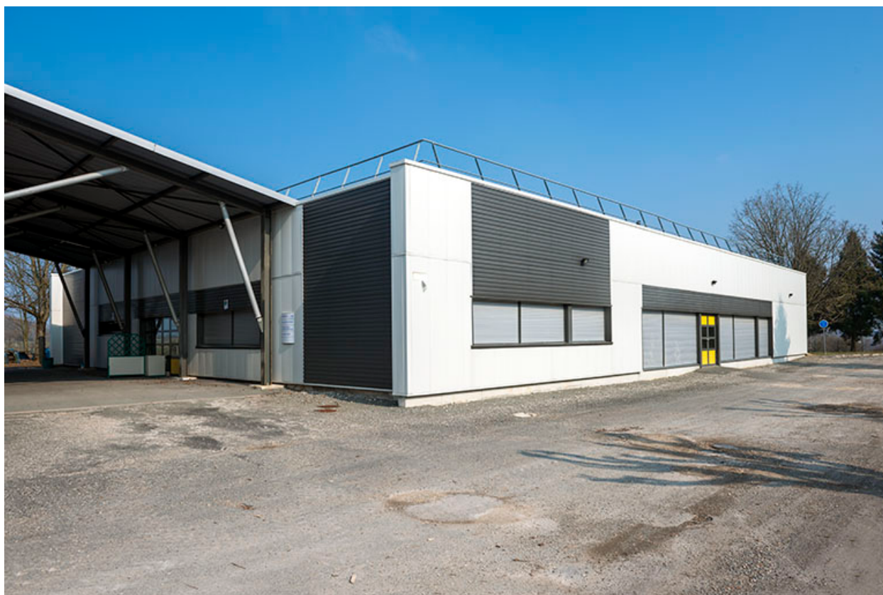
Angle sud-ouest de l'atelier est.
