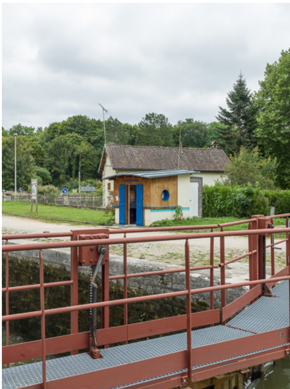
Vue de la maison éclusière.
