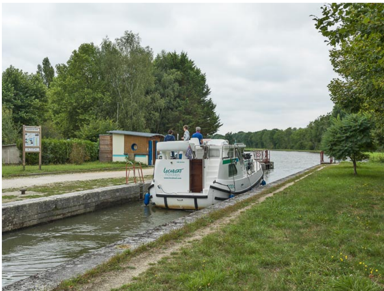
Vue du site d'écluse.
