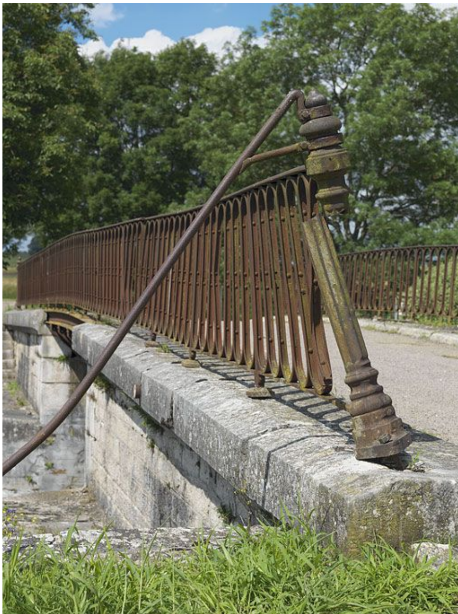
Pont sur écluse : détail du garde-corps.
