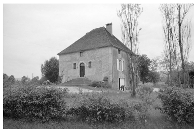
Logement d'ouvriers et bureau. Phot. Jack Dumont IVR43_19803900339Z
