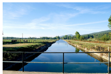
Le canal d'amenée depuis la prise d'eau. Phot. Yves Sancey IVR43_19973901240ZA
