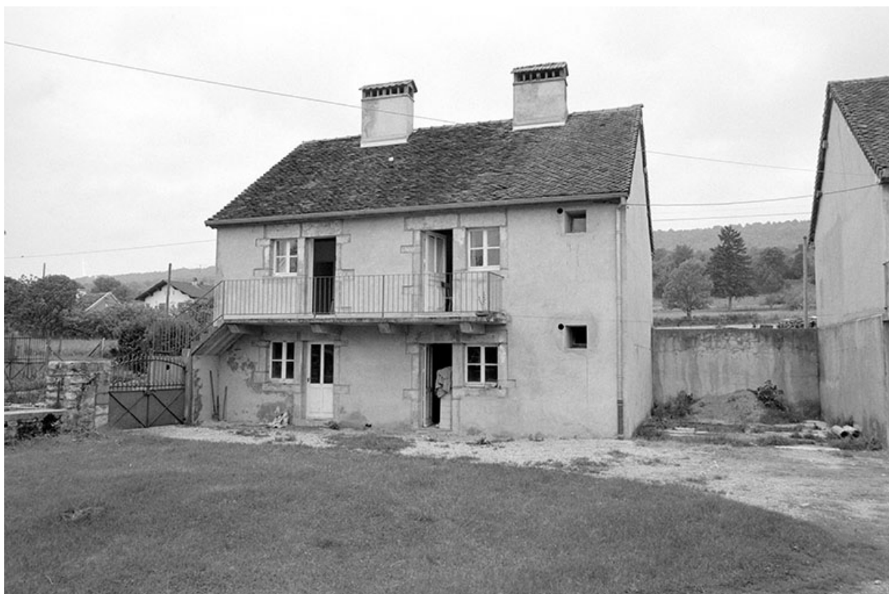
Façade sur cour d'un logement ouvrier.
