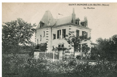
Élévation sur la rue, vue depuis depuis l'Hôtel Bellevue.
